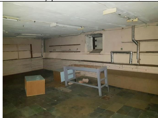
Фото 13. Внутреннее состояние Объекта оценки
