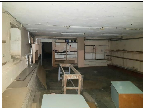
Фото 11. Внутреннее состояние Объекта оценки
