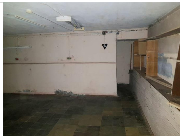
Фото 12. Внутреннее состояние Объекта оценки
