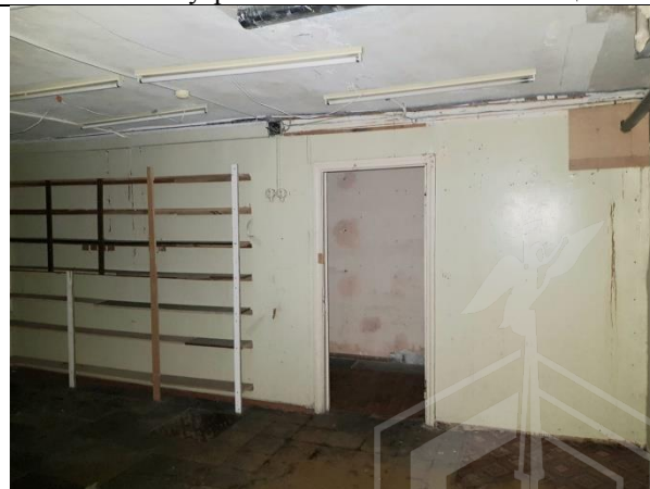
Фото 18. Внутреннее состояние Объекта оценки
