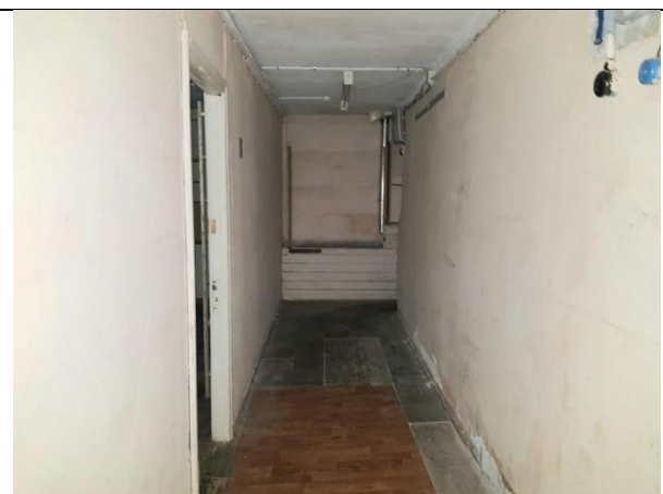
Фото 20. Внутреннее состояние Объекта оценки
