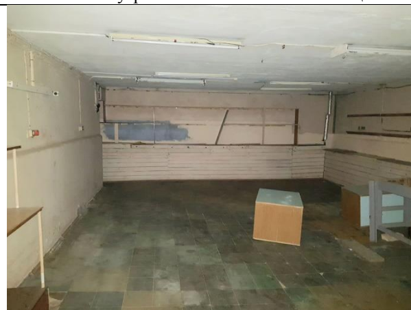
Фото 15. Внутреннее состояние Объекта оценки
