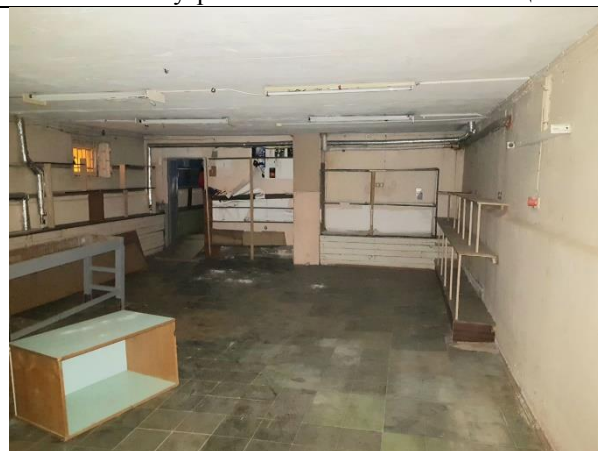
Фото 16. Внутреннее состояние Объекта оценки
