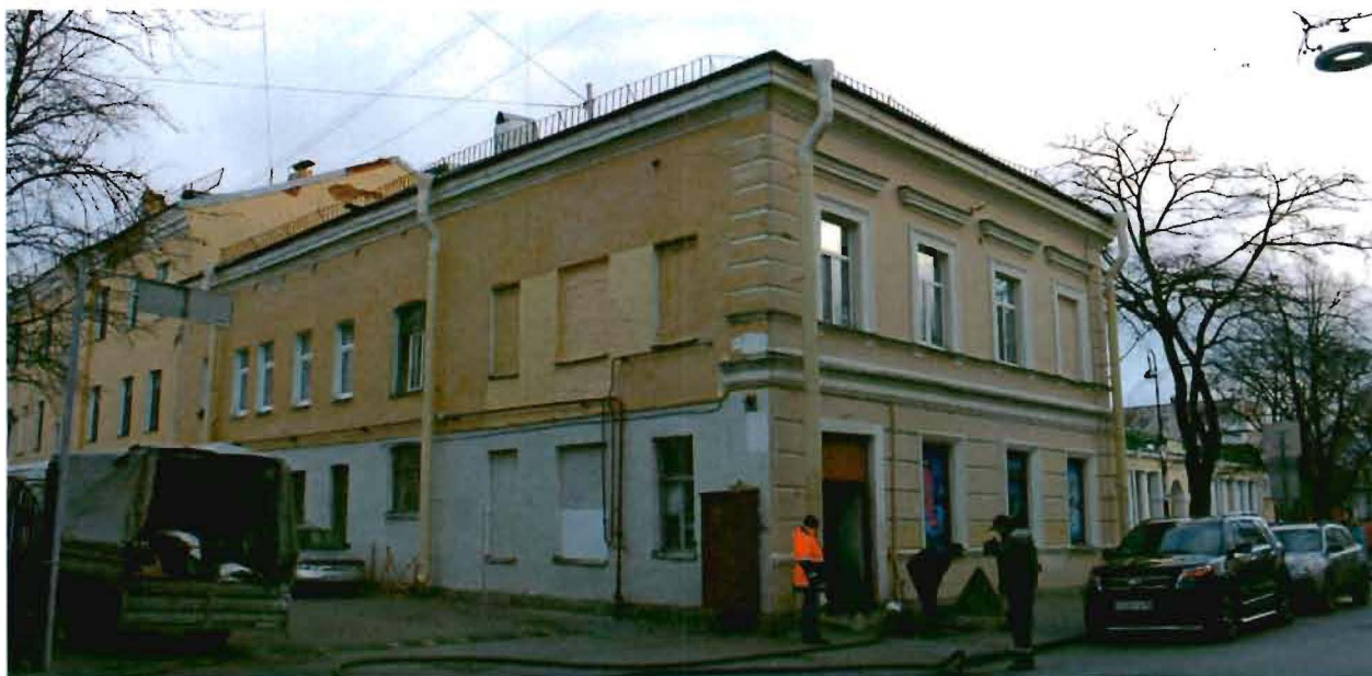
Фото №3. Вид на западный и южный фасады со стороны ул. Александра Попова.
