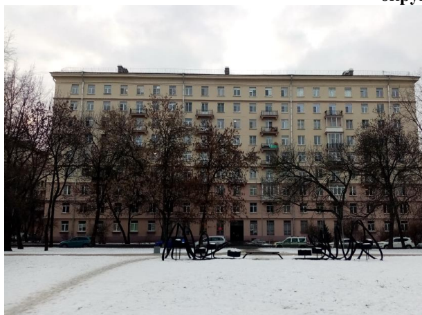
Фото 1. Вид здания, в котором расположен Объект оценки
