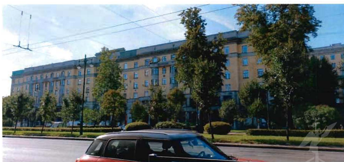
2. Общий вид. Восточный фасад южного флигеля.
