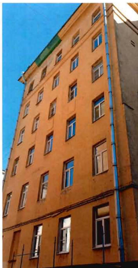
8. Фрагмент. Западный фасад северного флигеля.
