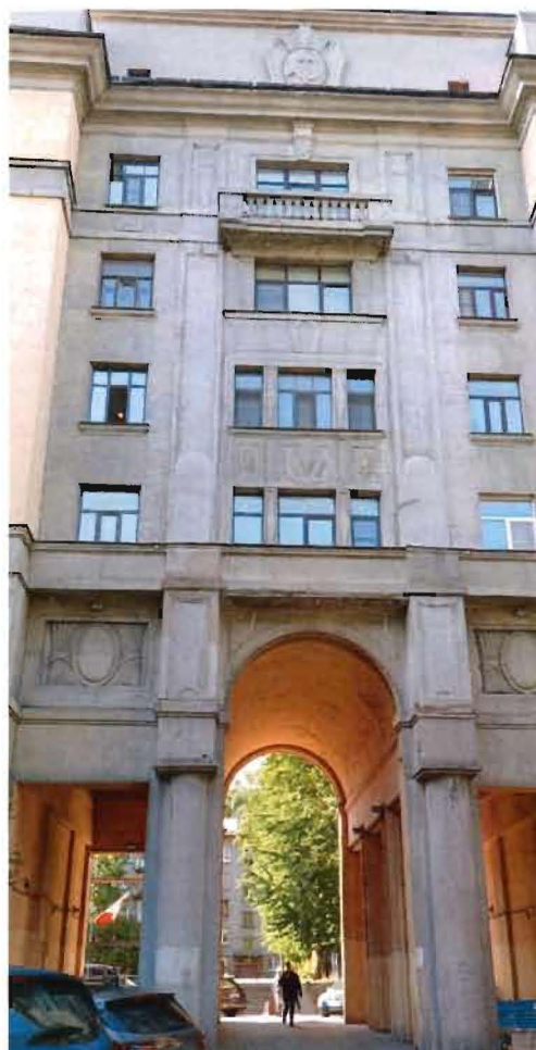
3. Фрагмент. Восточный фасад южного флигеля.
