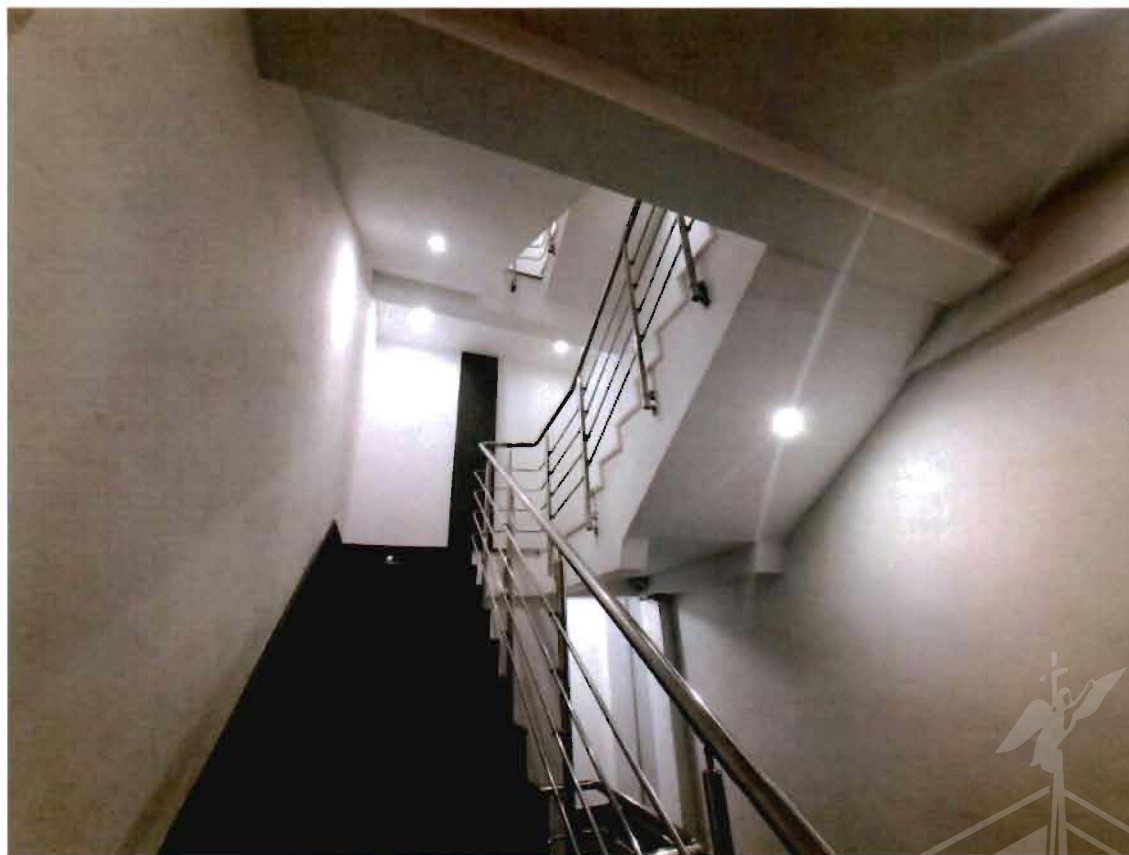
17. Двухмаршевая лестница в восточной части юго-восточного корпуса (27.06.2022)
