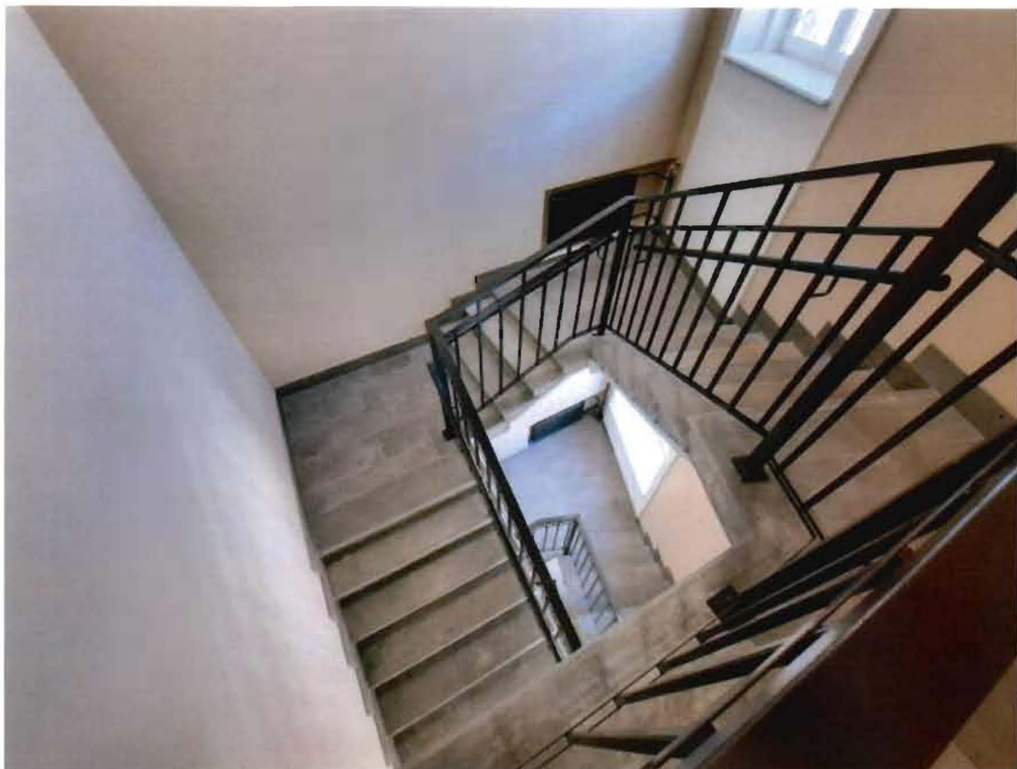
12. Четырехмаршевая лестница в западной части северо-западного корпуса (30.06.2022)
