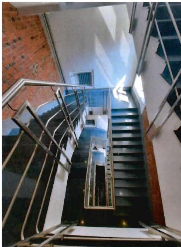
16. Двухмаршевая лестница в башне юго-восточного корпуса (27.06.2022)
