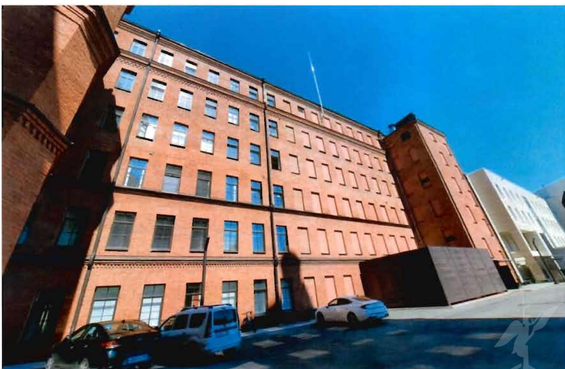
7. Фрагмент юго-восточного фасада объекта культурного наследия (27.06.2022)
