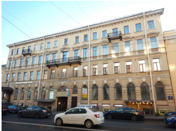
Фото №3 (вход в помещение)
