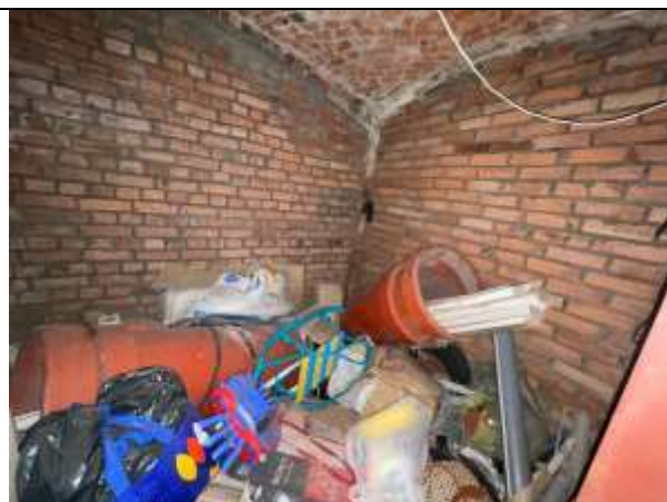
Фото 20. Типичное состояние Объекта оценки
