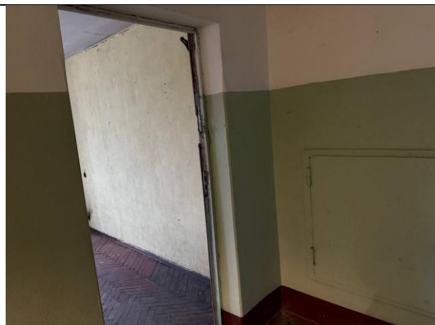
Фото № 6 – Вход в помещение
