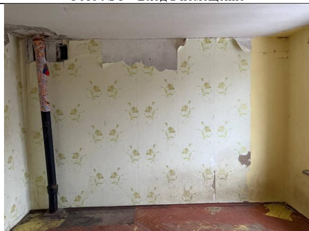
Фото № 8 – Внутреннее состояние помещения
