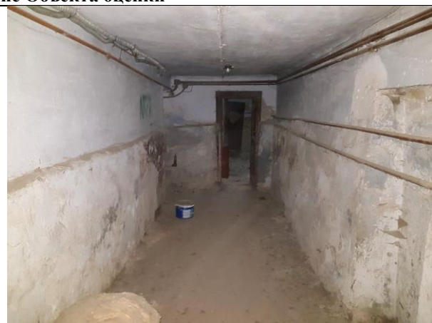
Фото 8. Внутреннее состояние Объекта оценки
