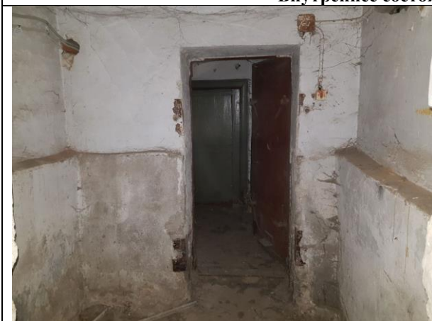
Фото 7. Внутреннее состояние Объекта оценки
