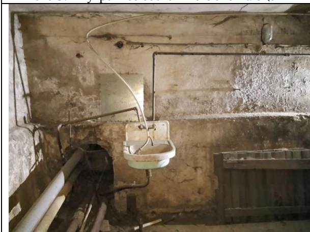
Фото 11. Внутреннее состояние Объекта оценки
