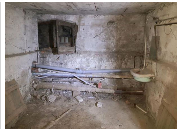
Фото 9. Внутреннее состояние Объекта оценки
