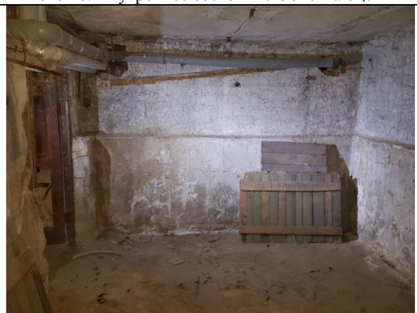
Фото 12. Внутреннее состояние Объекта оценки
