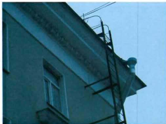
13. Профилированный карниз.
