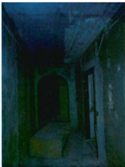
17. Помещение первого этажа.
