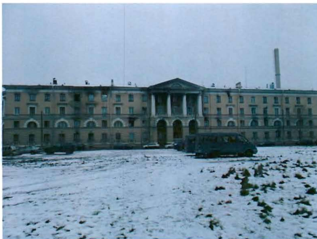
1. Лицевой фасад. Вид с юго-запада.
