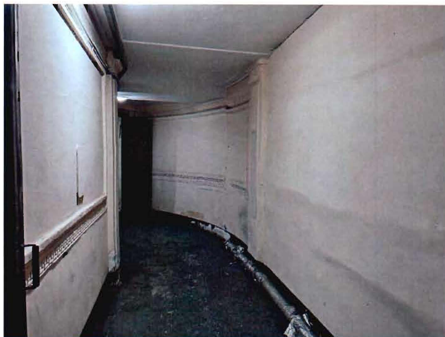
7. Помещение 2ЛК объекта культурного наследия.
