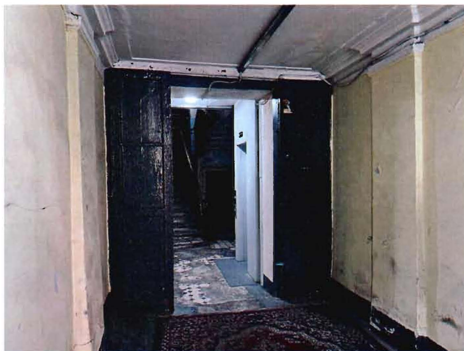
5. Помещение 1ЛК объекта культурного наследия.
