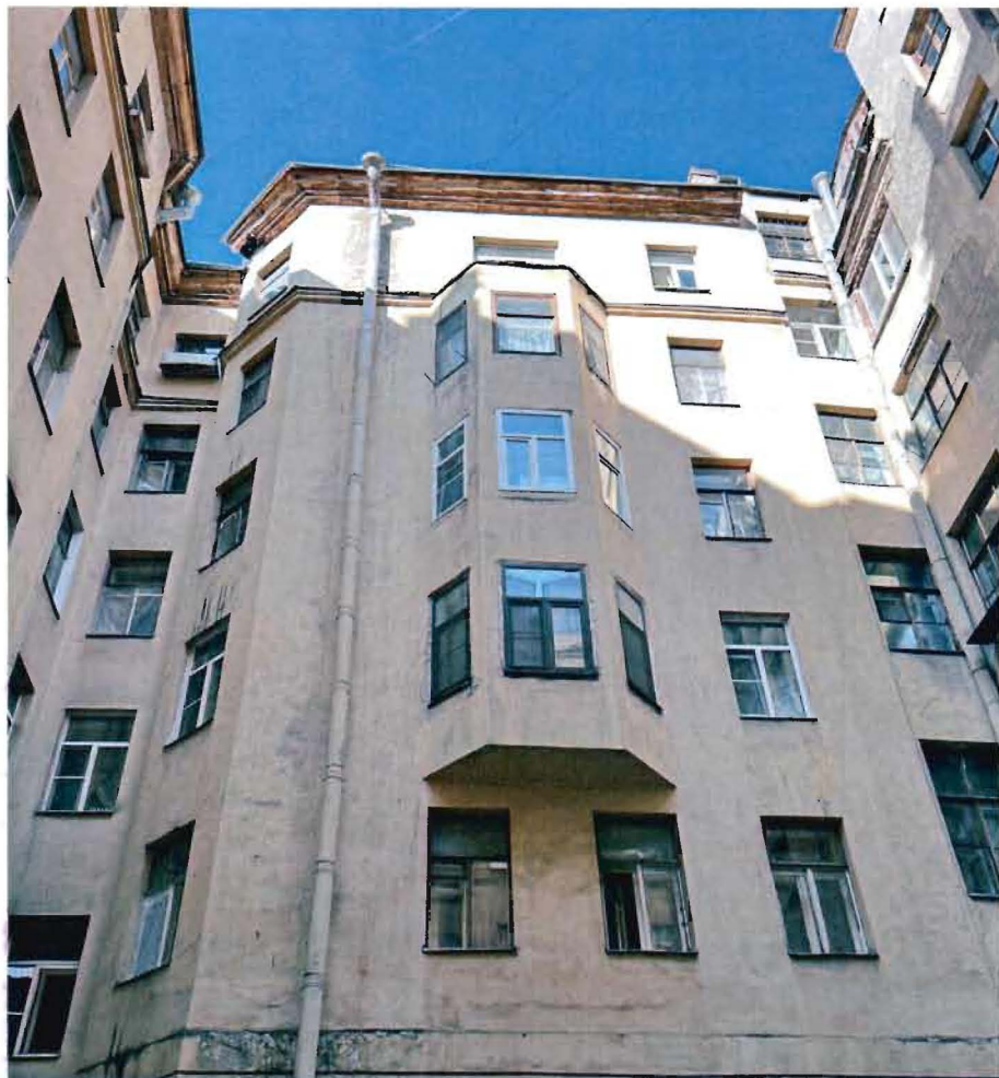
3. Дворовые фасады объекта культурного наследия.
