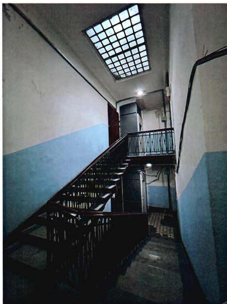
6. Лестница 1ЛК объекта культурного наследия.
