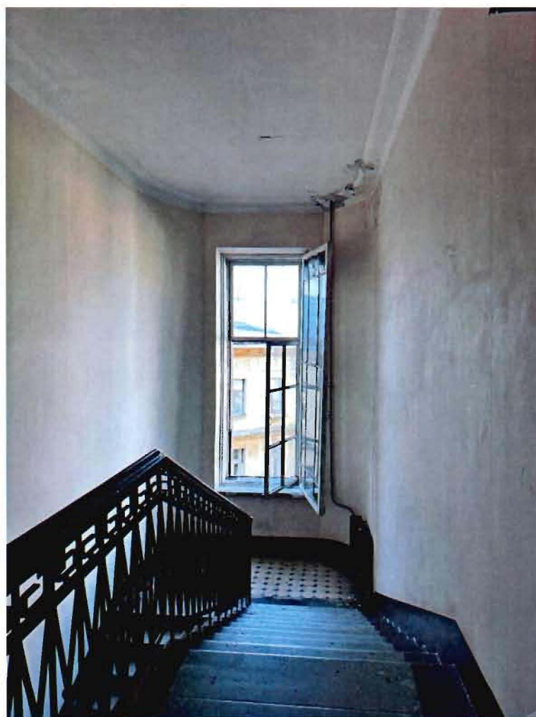
8. Лестница 2ЛК объекта культурного наследия.
