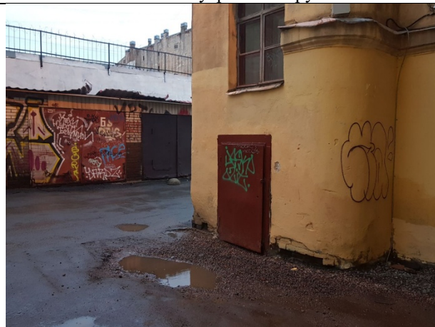
Фото № 6 – Вход в помещение.
