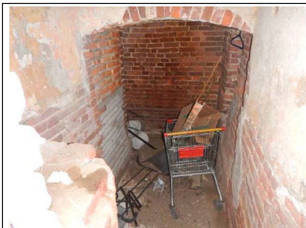
Фото № 7 – Внутреннее состояние помещения
