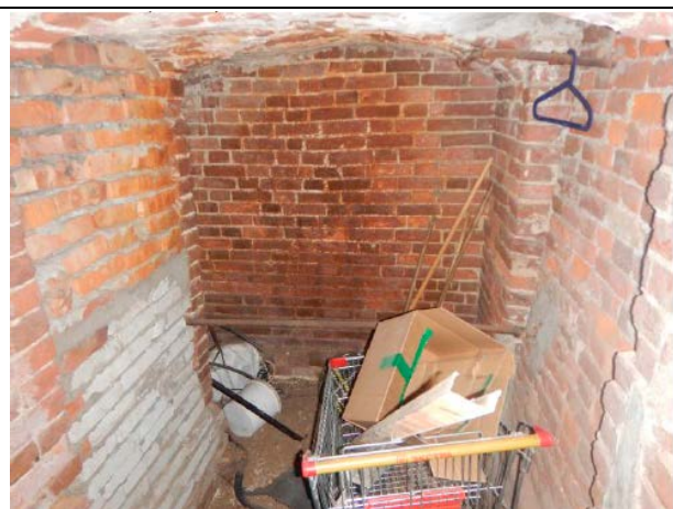
Фото № 8 – Внутреннее состояние помещения
