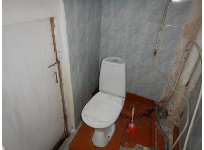
Фото №16 (ч.п.2 пом. б/н)
