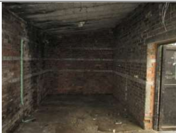
Фото № 15. Внутреннее состояние здания
