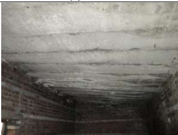
Фото № 13. Внутреннее состояние здания
