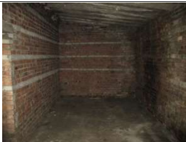
Фото № 12. Внутреннее состояние здания
