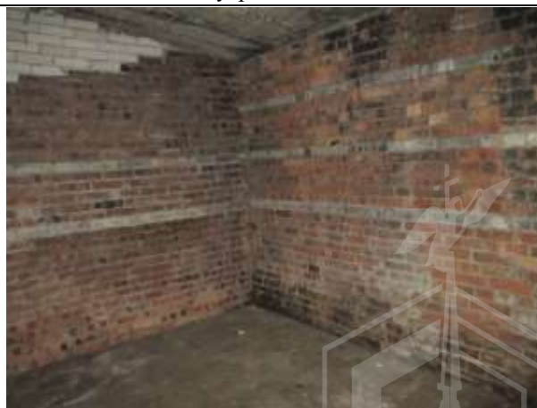
Фото № 14. Внутреннее состояние здания
