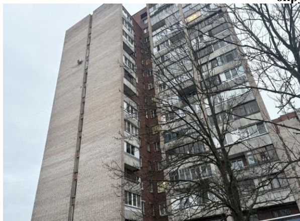
Фото 1. Вид здания Объекта оценки
