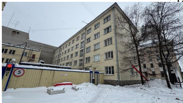
Фото 1. Вид здания, в котором расположен Объект оценки
