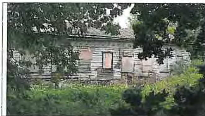
Фото 1. Вид на западный фасад Объекта
