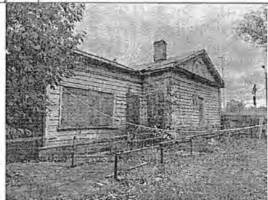
6. Фрагмент северного фасада
