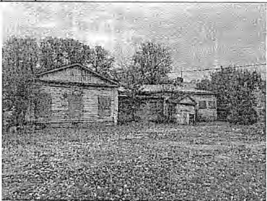
5. Фрагмент северного фасада
