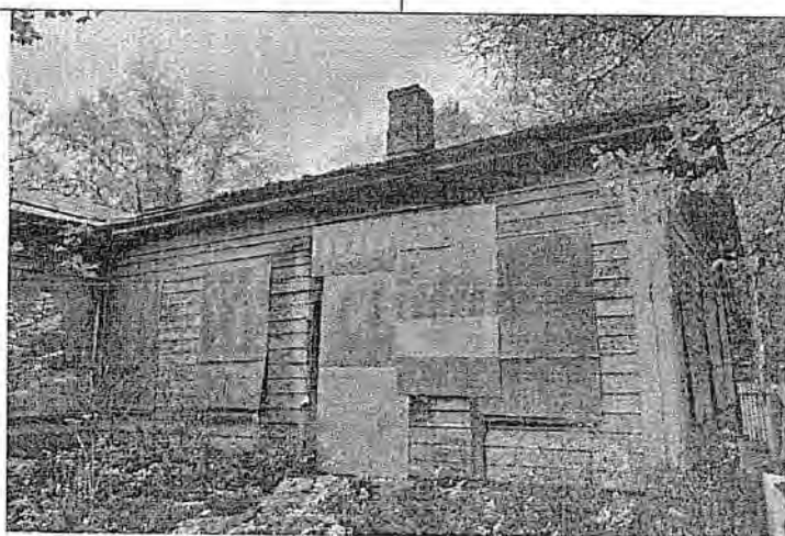
17. Фасад восточного бокового объема здания, обращенный к палисаднику. Проемы защиты фанерными щитами. Дефекты карнизной зоны, утраты кладки дымовых труб
