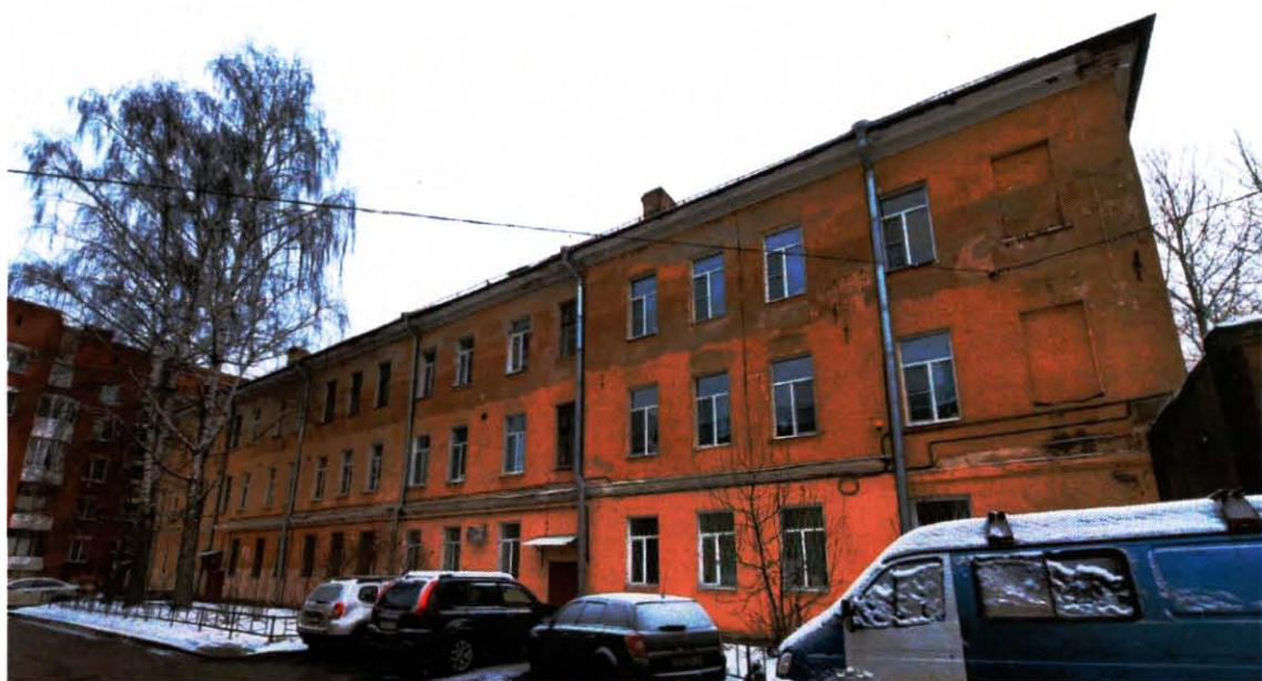
Фото 1 Общий вид. Западный дворовый фасад. Фото выполнено 12.02.2025.
