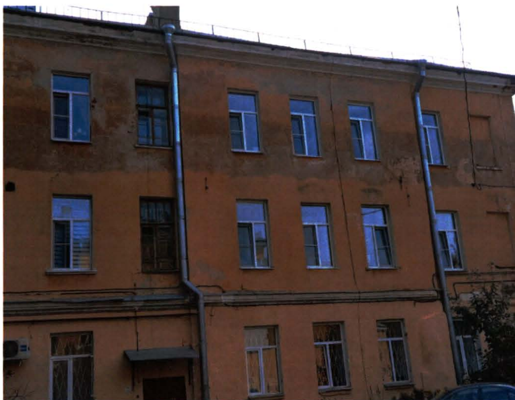
Фото 7 Фрагмент объекта культурного наследия. Западный дворовый фасад. Вид с запада Фото выполнено 30.07.2024.
