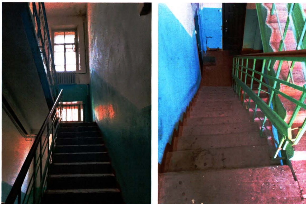
Фото 15, 16 Фрагмент объекта культурного наследия. Лестница 2 ЛК. Фото выполнено 30.07.2024.
