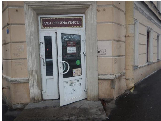
Фото №4 (вход в помещение)
