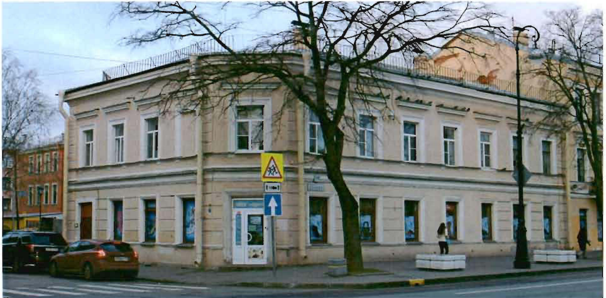
Фото №1. Вид со стороны просп. Ленина.
