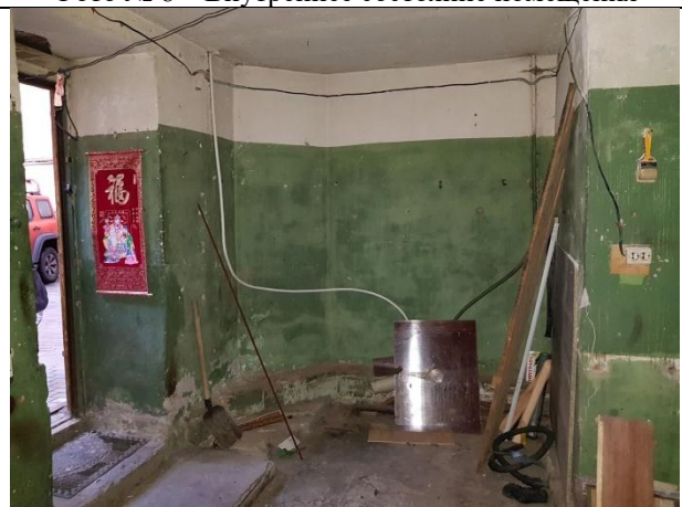
Фото № 10 – Внутреннее состояние помещения
