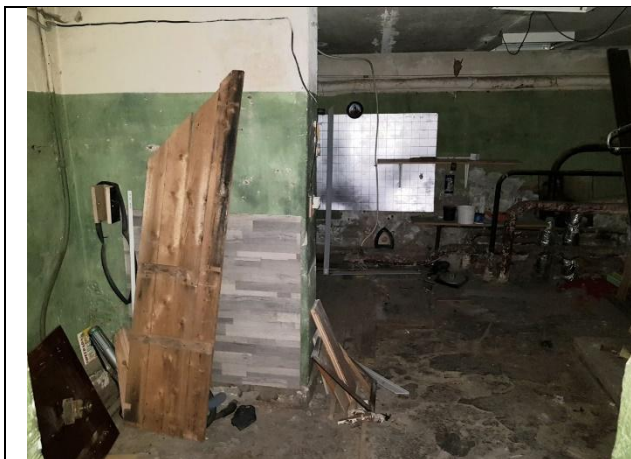
Фото № 7 – Внутреннее состояние помещения
