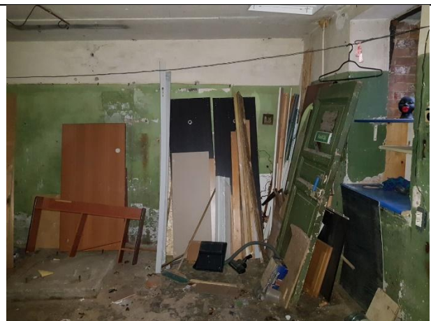
Фото № 8 – Внутреннее состояние помещения
