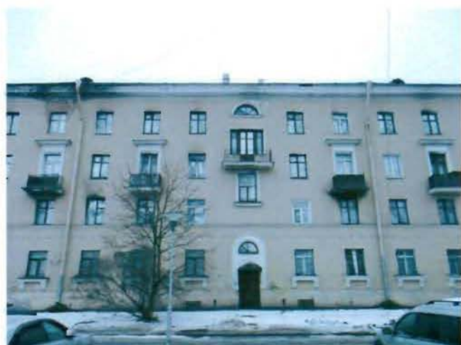
5. Фрагмент фасада. Вид с северо-востока.
