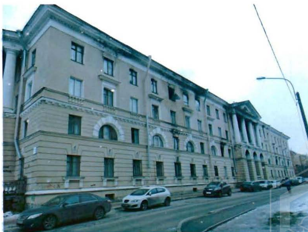
2. Лицевой фасад. Вид с запада.
