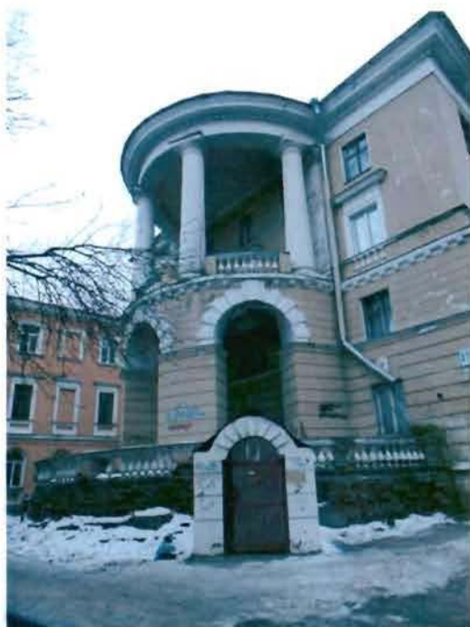
9. Полуциркульный ризалит с балконом и террасой.
