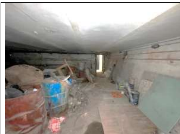
Фото 27. Типичное состояние Объекта оценки
