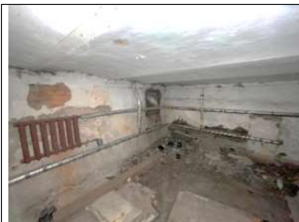
Фото 33. Типичное состояние Объекта оценки
