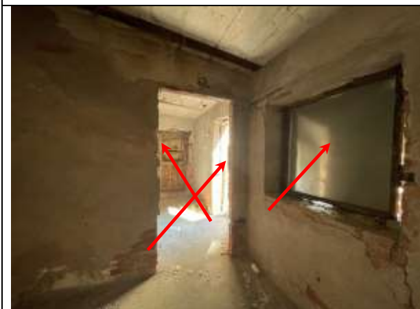
Фото 26. Типичное состояние Объекта оценки, оконная и входная группа Объекта оценки
