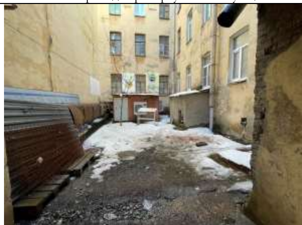
Фото 33. Внутридворовая территория Объекта оценки
