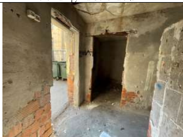
Фото 27. Типичное состояние Объекта оценки
