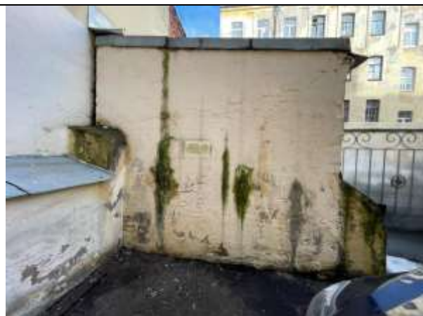
Фото 24. Вид здания расположения Объекта оценки
