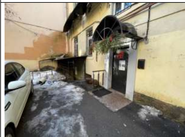
Фото 19. Внутридворовая территория Объекта оценки
