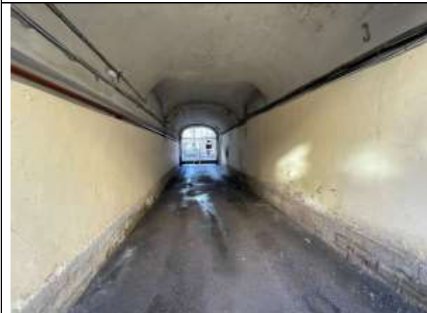
Фото 17. Проход через арку к Объекту оценки
