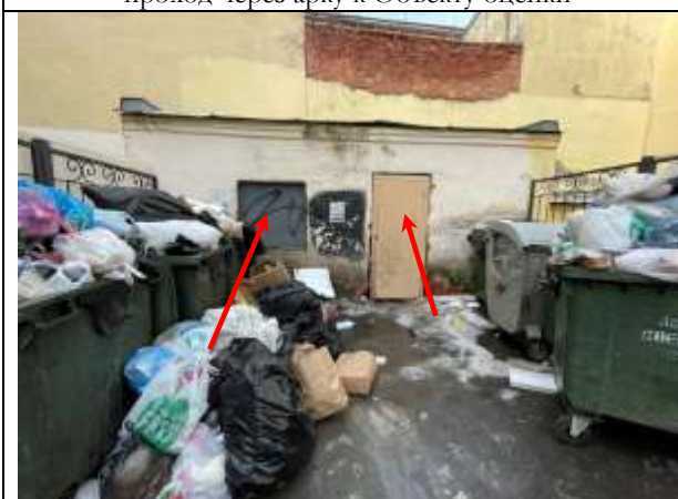
Фото 25. Входная и оконная группа Объекта оценки
