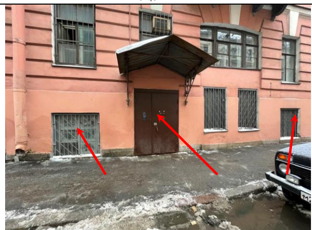
Фото 18. Входная и оконная группа Объекта оценки
