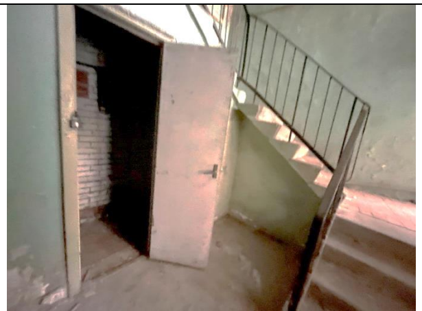
Фото 56. Лестничный проём Объекта оценки
