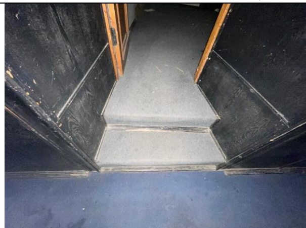
Фото 74. Типичное состояние Объекта оценки
