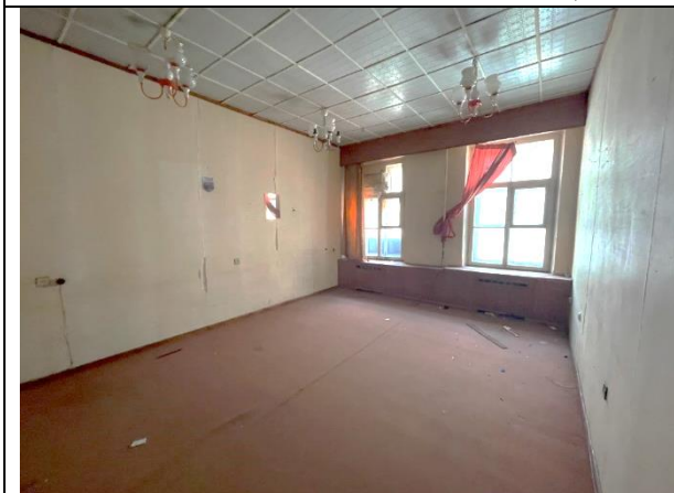
Фото 81. Типичное состояние Объекта оценки
