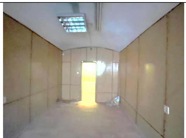
Фото 24. Типичное состояние Объекта оценки
