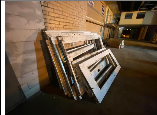
Фото 19 Стальной лом и сэндвич панели
