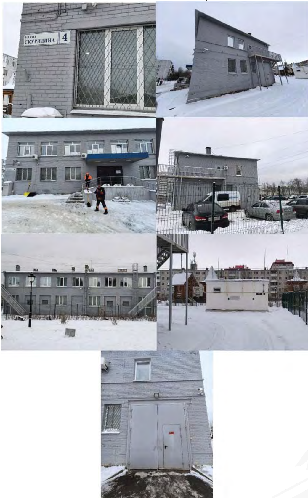
Внешний вид здания и окружения
