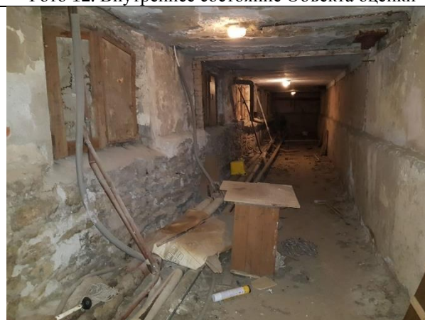
Фото 14. Внутреннее состояние Объекта оценки
