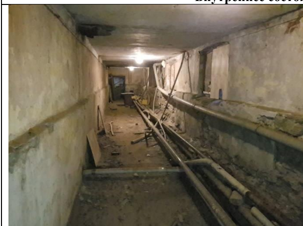
Фото 7. Внутреннее состояние Объекта оценки
