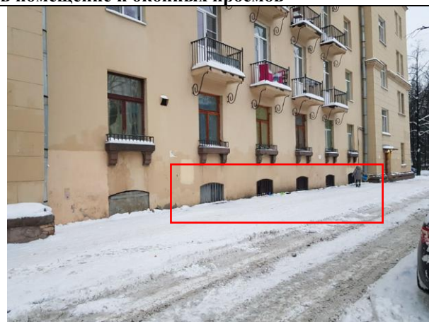
Фото 6. Вид окон Объекта оценки
