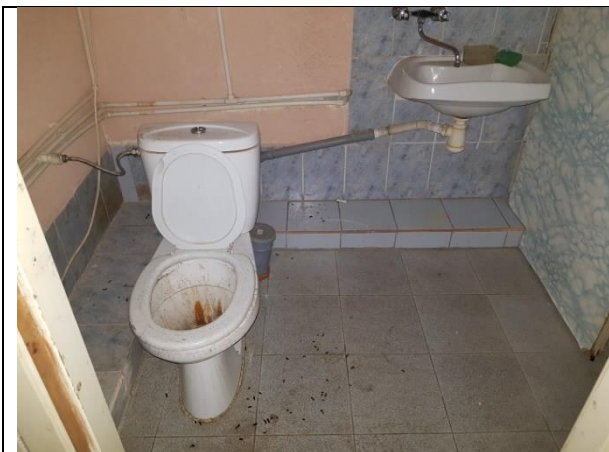
Фото 19. Внутреннее состояние Объекта оценки
