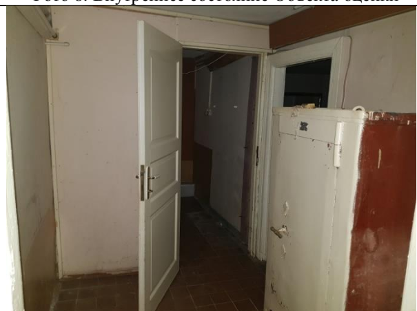
Фото 10. Внутреннее состояние Объекта оценки
