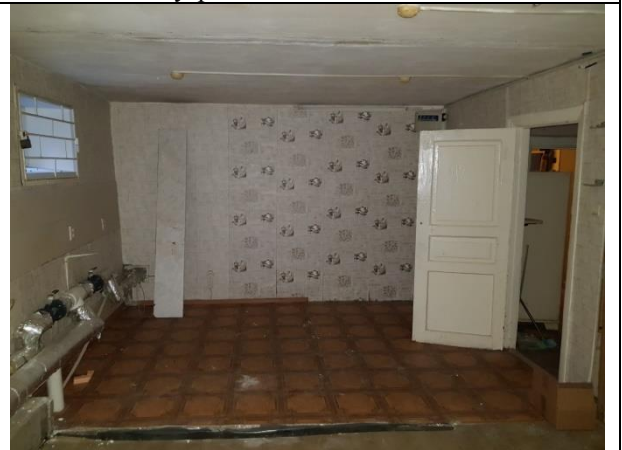
Фото 14. Внутреннее состояние Объекта оценки
