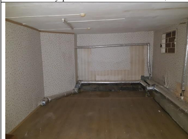
Фото 15. Внутреннее состояние Объекта оценки
