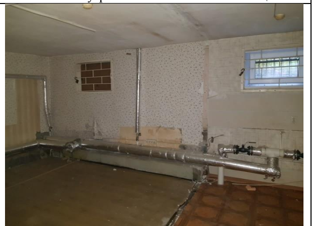
Фото 16. Внутреннее состояние Объекта оценки
