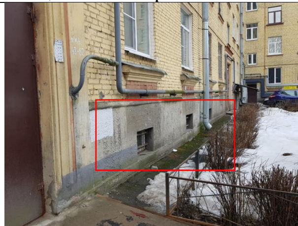
Фото 6. Вид окон Объекта оценки
