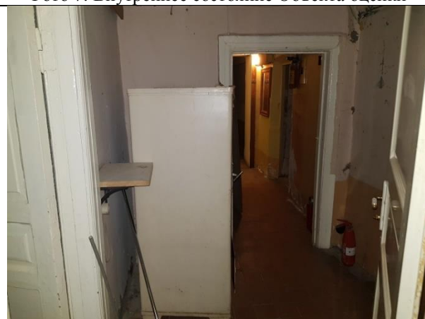
Фото 9. Внутреннее состояние Объекта оценки
