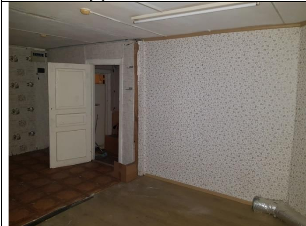
Фото 13. Внутреннее состояние Объекта оценки
