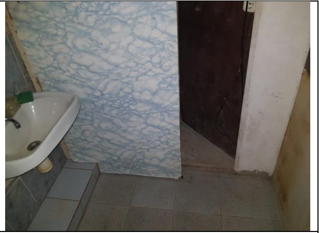
Фото 12. Внутреннее состояние Объекта оценки
