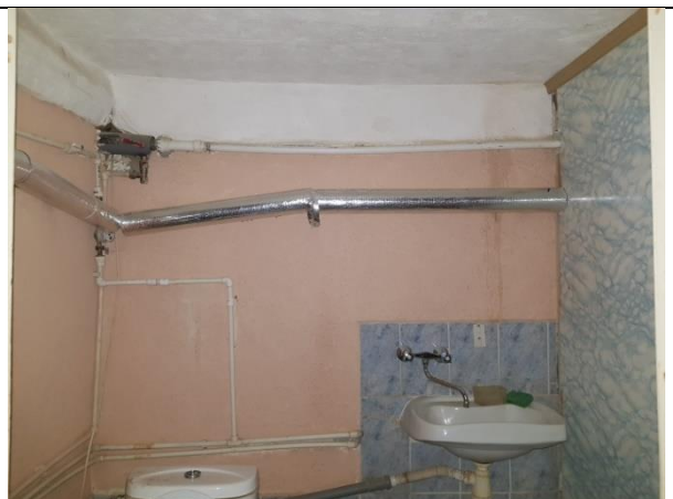
Фото 20. Внутреннее состояние Объекта оценки
