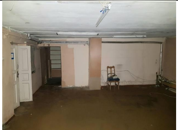
Фото 16. Внутреннее состояние Объекта оценки
