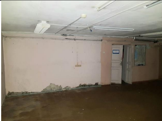
Фото 15. Внутреннее состояние Объекта оценки
