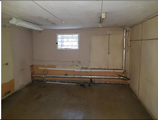
Фото 11. Внутреннее состояние Объекта оценки
