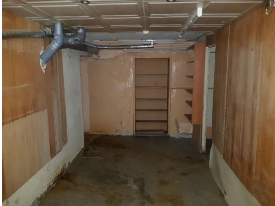
Фото 13. Внутреннее состояние Объекта оценки
