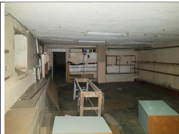
Фото 11. Внутреннее состояние Объекта оценки
