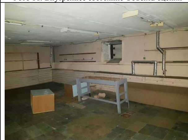
Фото 13. Внутреннее состояние Объекта оценки
