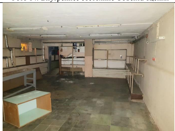
Фото 16. Внутреннее состояние Объекта оценки
