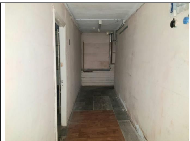
Фото 20. Внутреннее состояние Объекта оценки
