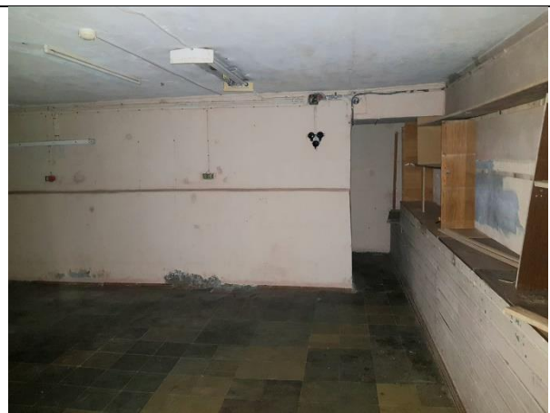
Фото 12. Внутреннее состояние Объекта оценки
