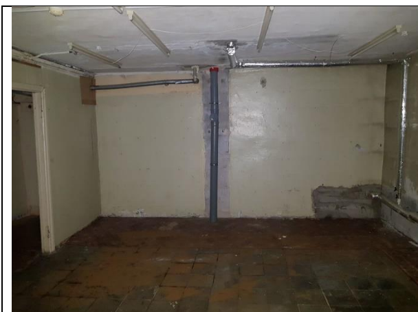
Фото 19. Внутреннее состояние Объекта оценки
