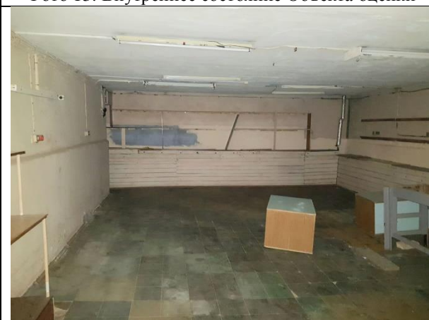
Фото 15. Внутреннее состояние Объекта оценки
