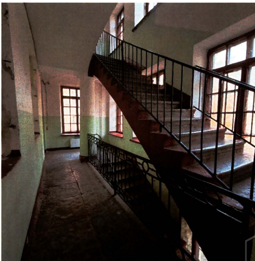
11. Северная лестница (2ЛК и Л-7) объекта культурного наследия (дворовая часть, лестница Л-7)
