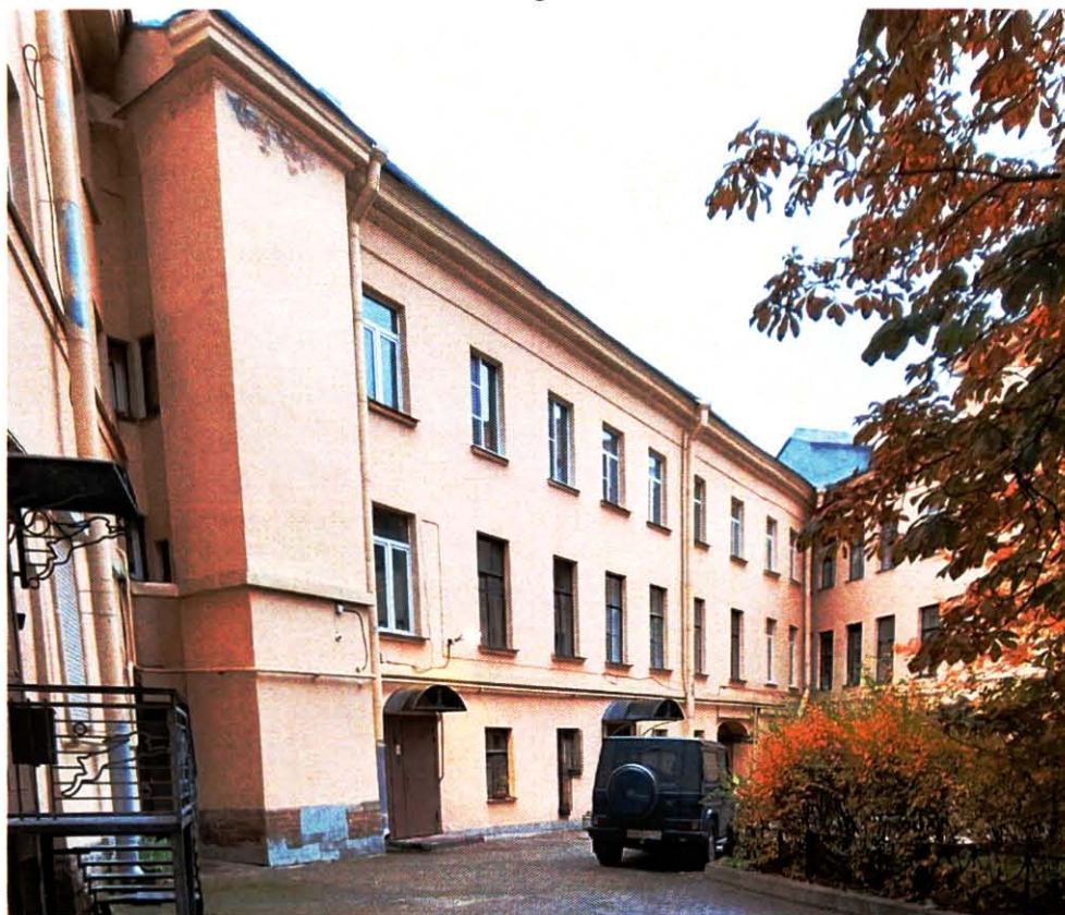
8. Общий вид на западный дворовый фасад объекта культурного наследия
