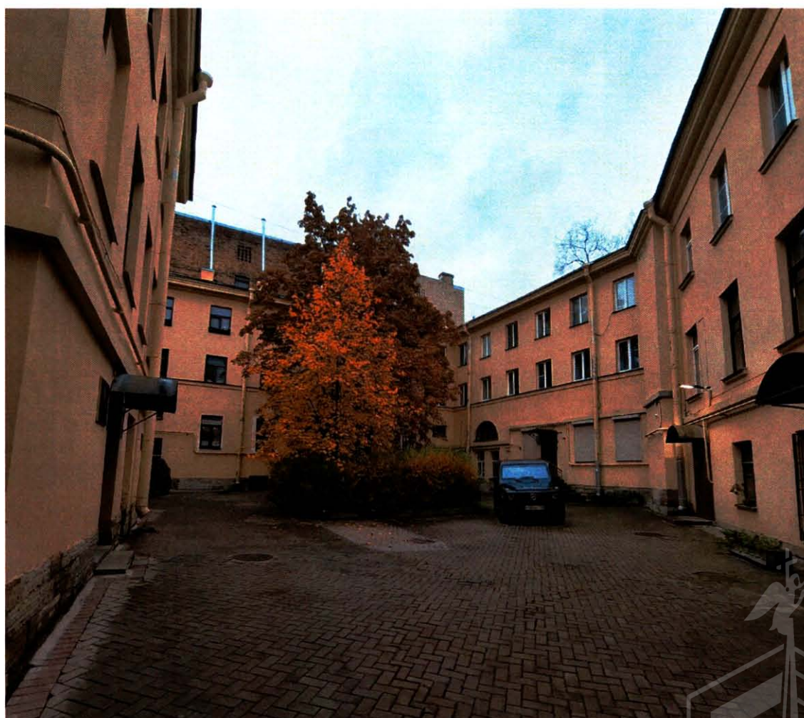
3. Общий вид на дворовые фасады и территорию объекта культурного наследия (вид с запада)
