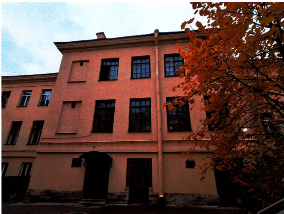
5. Фрагмент северного дворового фасада объекта культурного наследия
