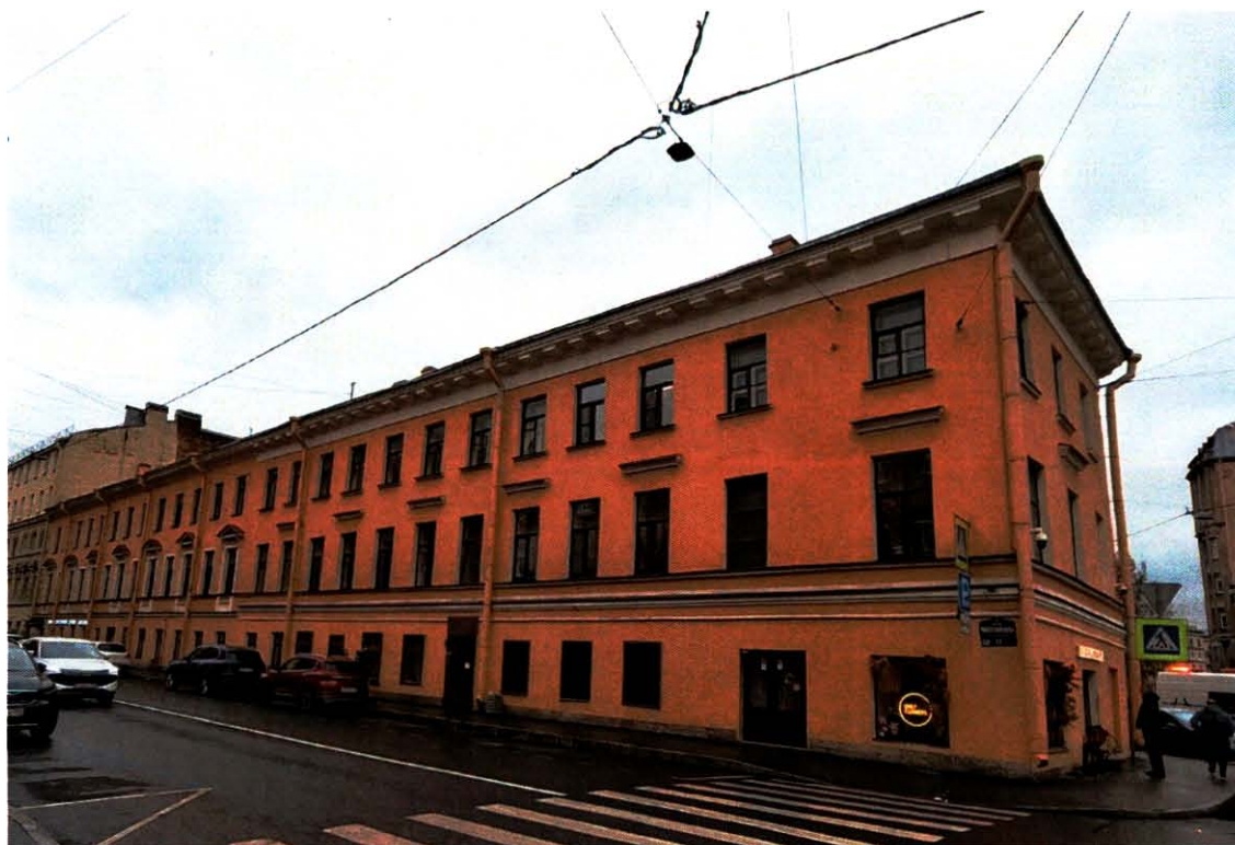
2. Общий вид на северный лицевой фасад объект культурного наследия
