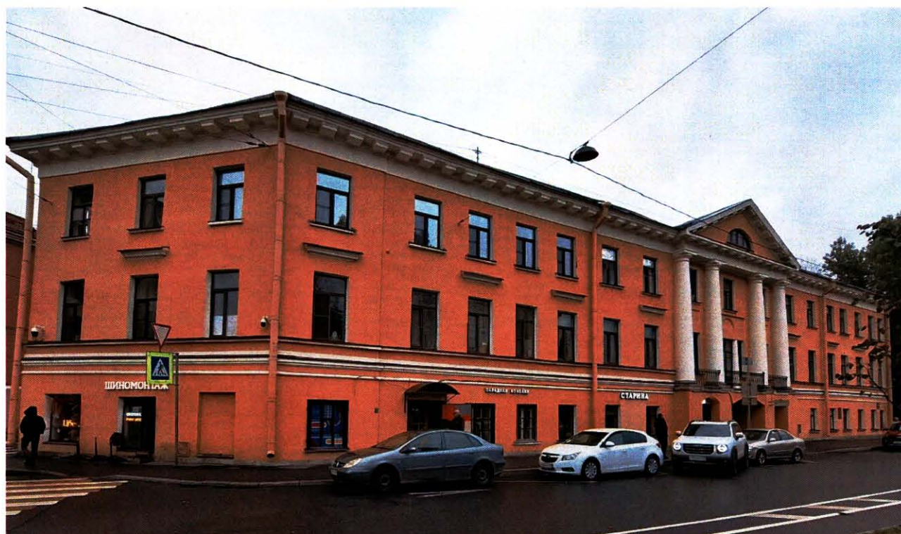
1. Общий вид на западный лицевой фасад объекта культурного наследия
