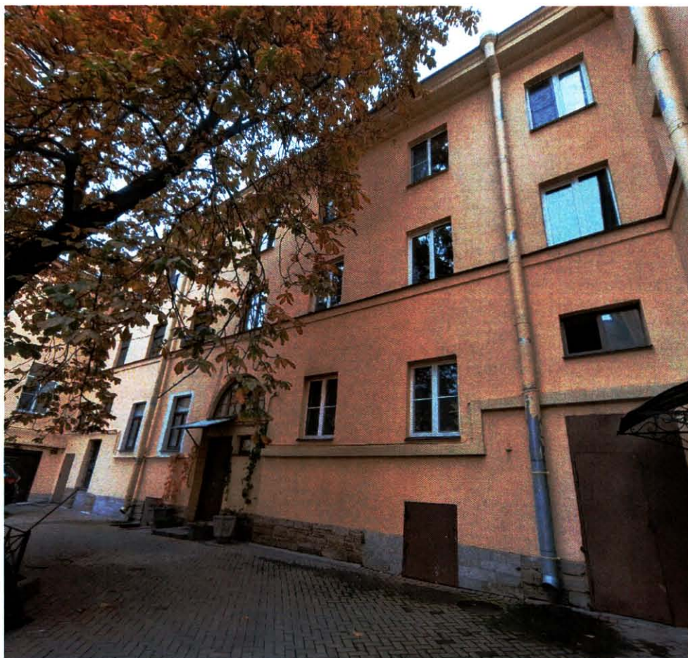
6. Общий вид на восточный дворовой фасад объекта культурного наследия
