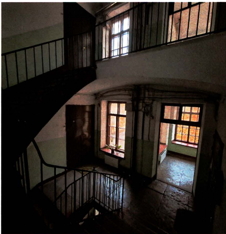
10. Северная лестница (2ЛК и Л-7) объекта культурного наследия (лицевая часть, лестница 2ЛК)
