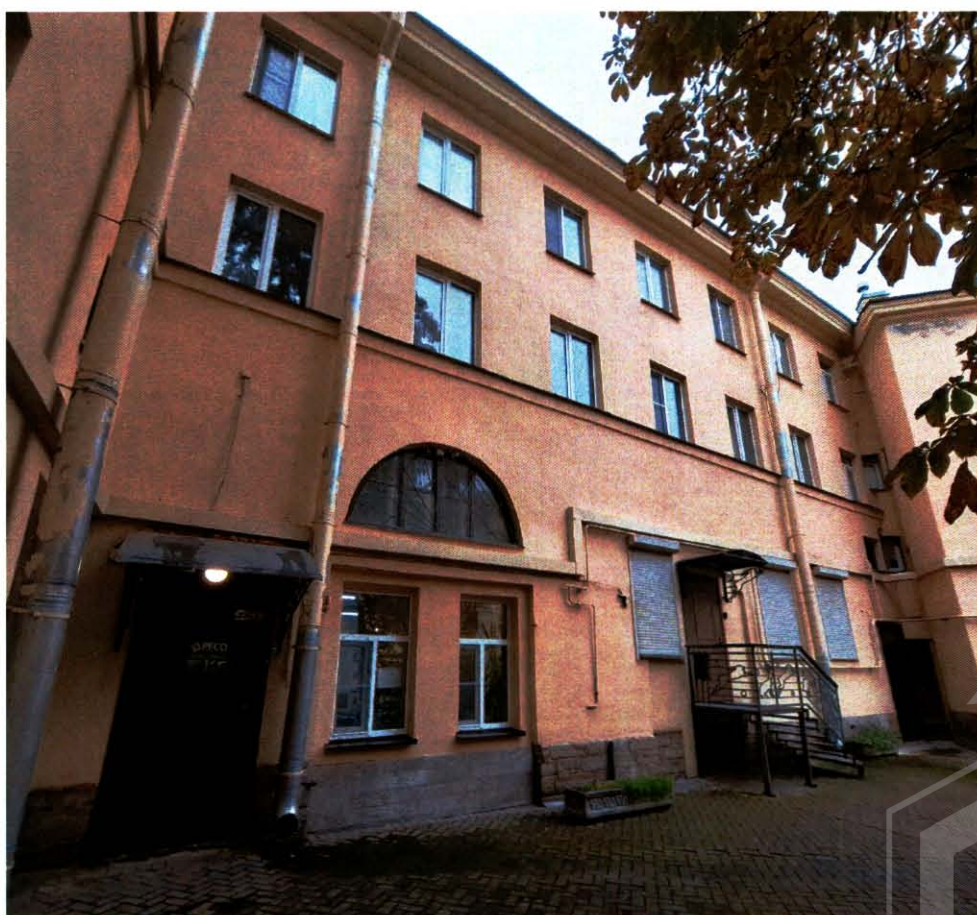
7. Общий вид на южный дворовой фасад объекта культурного наследия
