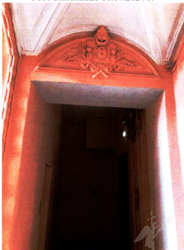
12. Помещение лестничной клетки Л-1 объекта культурного наследия. Фото выполнено 11.04.2024 г.
