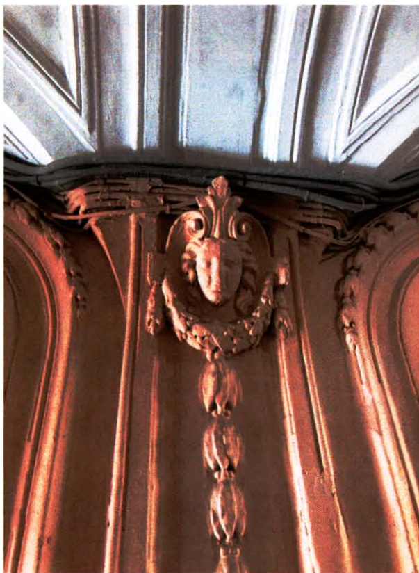
9. Помещение вестибюля лестничной клетки Л-1 объекта культурного наследия. Фото выполнено 11.04.2024 г.
