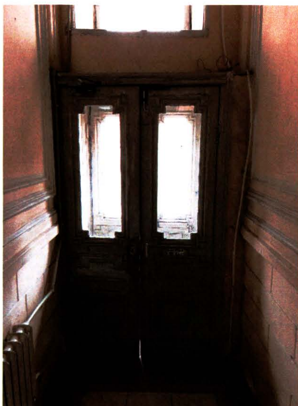
14. Помещение Л-2 объекта культурного наследия. Фото выполнено 19.04.2024
