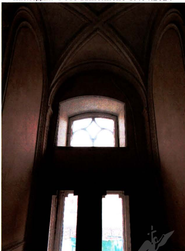
16. Помещение Л-2 объекта культурного наследия. Фото выполнено 19.04.2024
