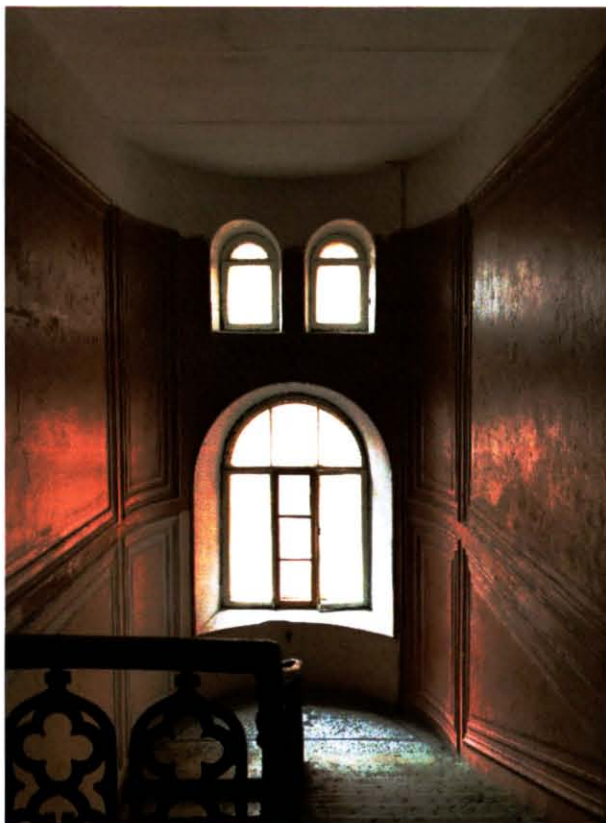
17. Помещение Л-2 объекта культурного наследия. Фото выполнено 19.04.2024
