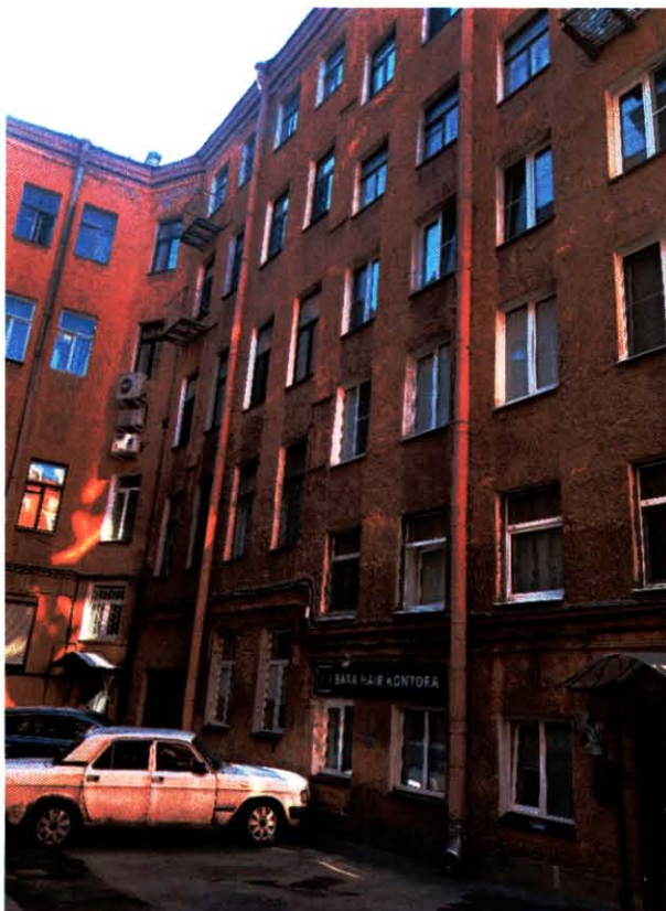
5. Фрагмент юго-западного дворового фасада объекта культурного наследия. Фото выполнено 11.04.2024 г.
