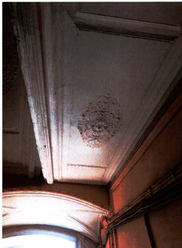
10. Помещение лестничной клетки Л-1 объекта культурного наследия. Фото выполнено 11.04.2024 г.
