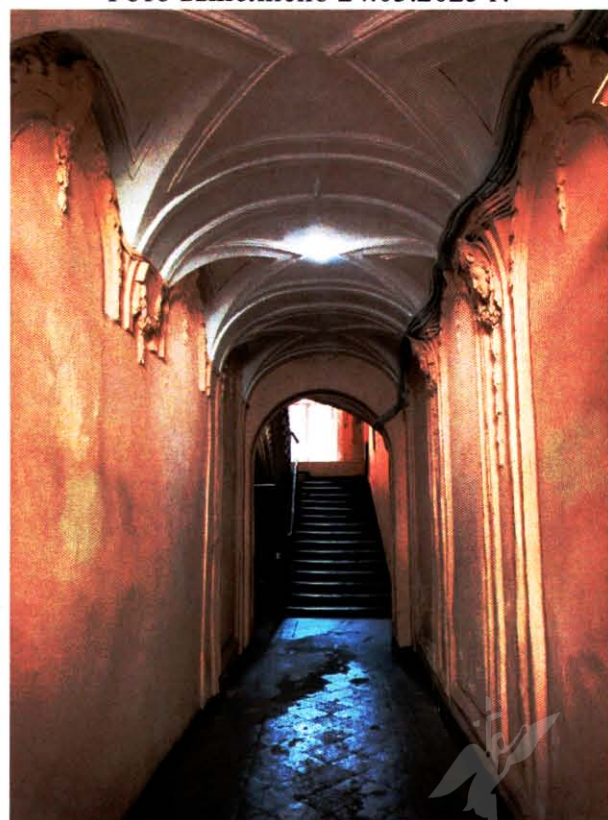
8. Помещение вестибюля лестничной клетки Л-1 объекта культурного наследия. Фото выполнено 11.04.2024 г.
