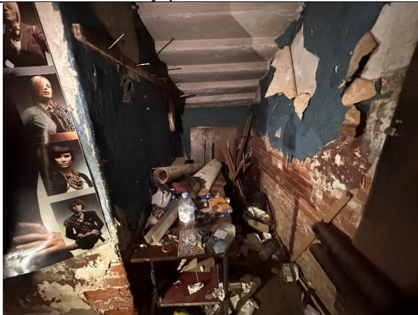
Фото № 13 – Внутреннее состояние помещения
