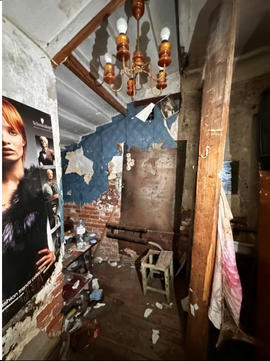
Фото № 9 – Внутреннее состояние помещения
