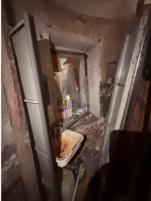
Фото № 11 – Внутреннее состояние помещения
