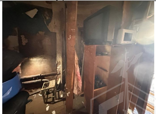
Фото № 14 – Внутреннее состояние помещения
