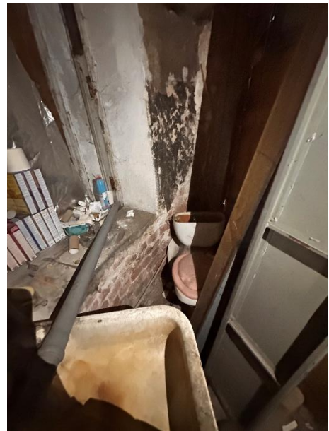
Фото № 12 – Внутреннее состояние помещения
