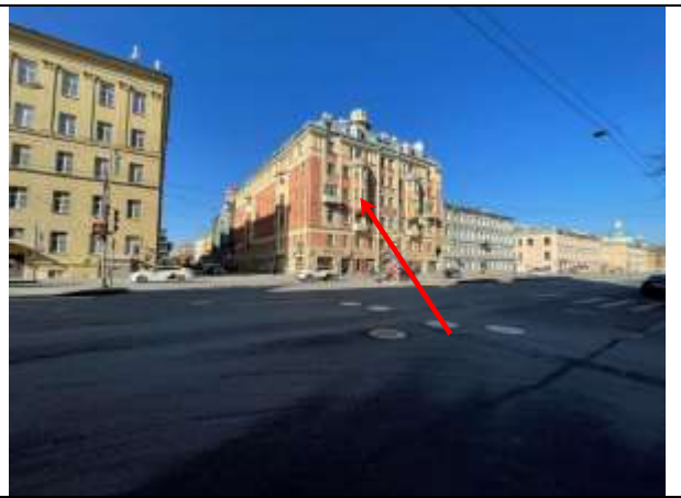
Фото 16. Вид здания Объекта оценки (пересечение улиц: Измайловский проспект, 12-я Красноармейская улица)
