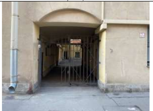
Фото 18. Проход через арку к Объекту оценки (12-я Красноармейская улица)
