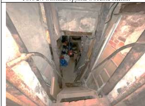
Фото 29. Типичное состояние Объекта оценки
