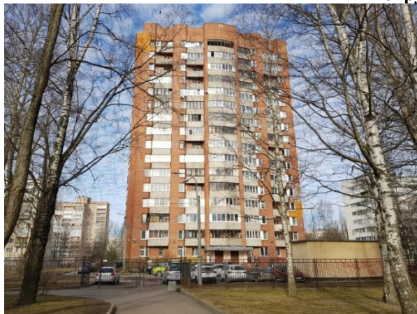
Фото 1. Вид здания, в котором расположен Объект оценки
