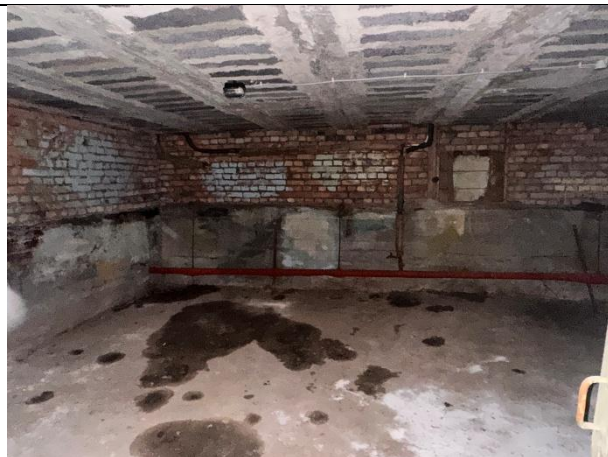
Фото № 13 – Внутреннее состояние помещения
