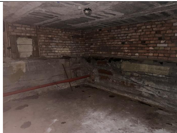
Фото № 14 – Внутреннее состояние помещения
