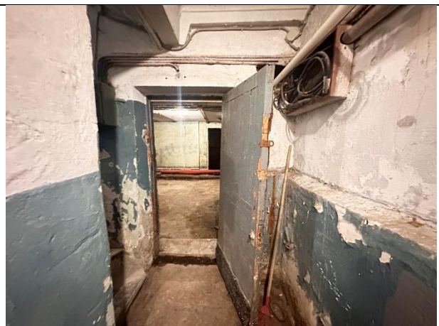
Фото № 8 – Вход в помещение
