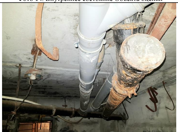
Фото 16. Внутреннее состояние Объекта оценки
