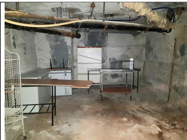
Фото 13. Внутреннее состояние Объекта оценки
