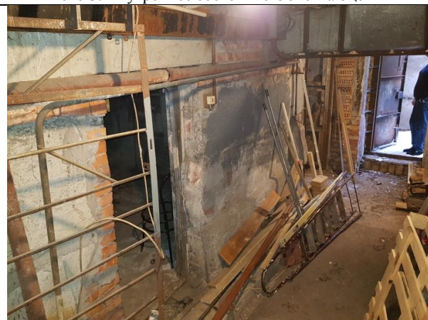
Фото 11. Внутреннее состояние Объекта оценки
