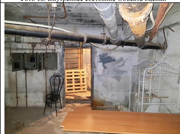
Фото 15. Внутреннее состояние Объекта оценки
