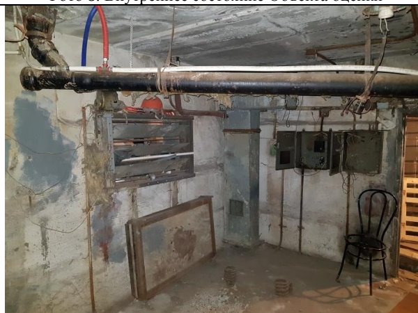
Фото 10. Внутреннее состояние Объекта оценки
