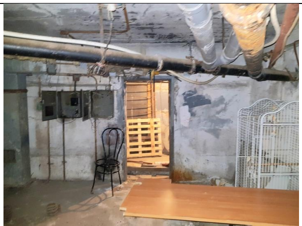
Фото 14. Внутреннее состояние Объекта оценки
