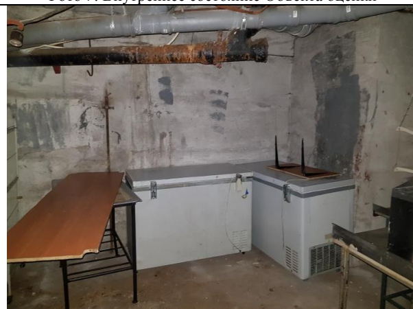
Фото 9. Внутреннее состояние Объекта оценки
