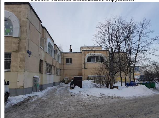
Фото 3. Вид здания, в котором расположен Объект оценки
