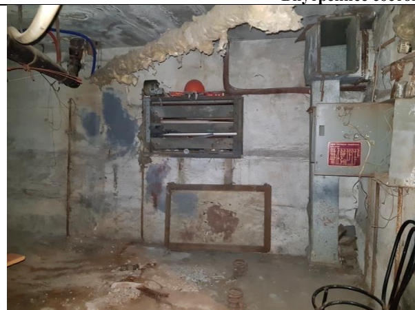
Фото 7. Внутреннее состояние Объекта оценки
