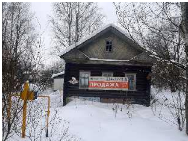
Фото 1. Дворовая территория. Вид на оцениваемый объект
