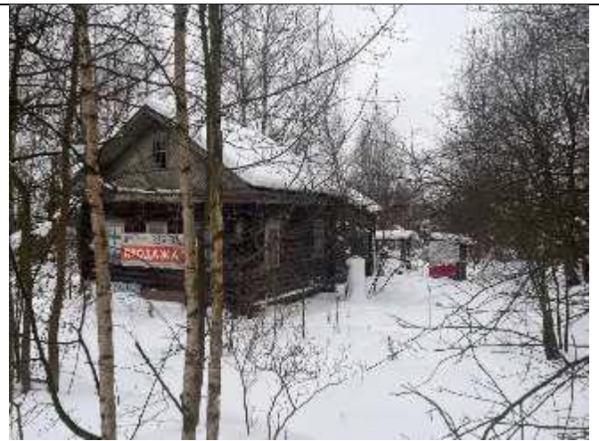
Фото 4 Вид на оцениваемый жилой дом.
