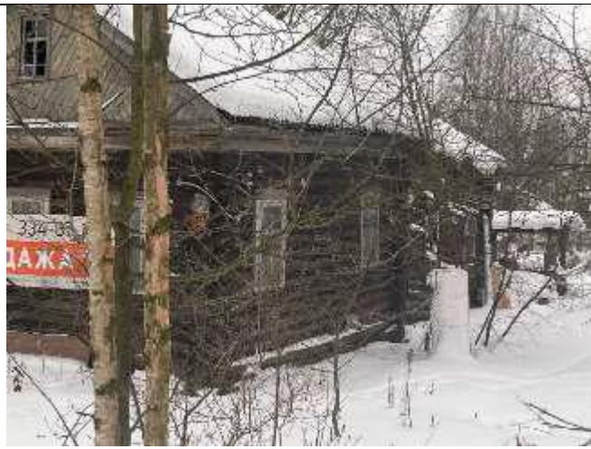
Фото 3 Вид на оцениваемый жилой дом.
