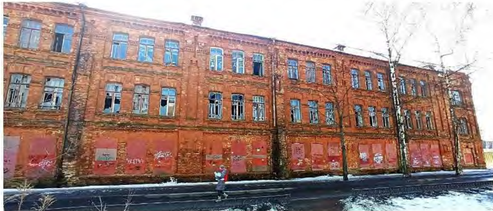
Фото 3. Вид на западную часть северного фасада
