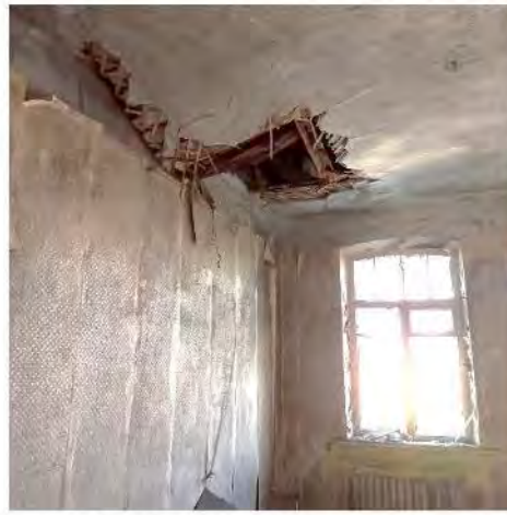
Фото 26. Вид на одно из помещений 3 этажа
