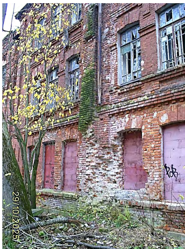
Фото 55. Часть южного фасада
