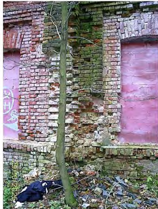
Фото 53. Часть южного фасада
