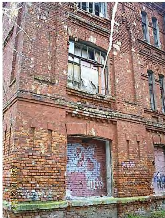
Фото 58. Часть южного фасада
