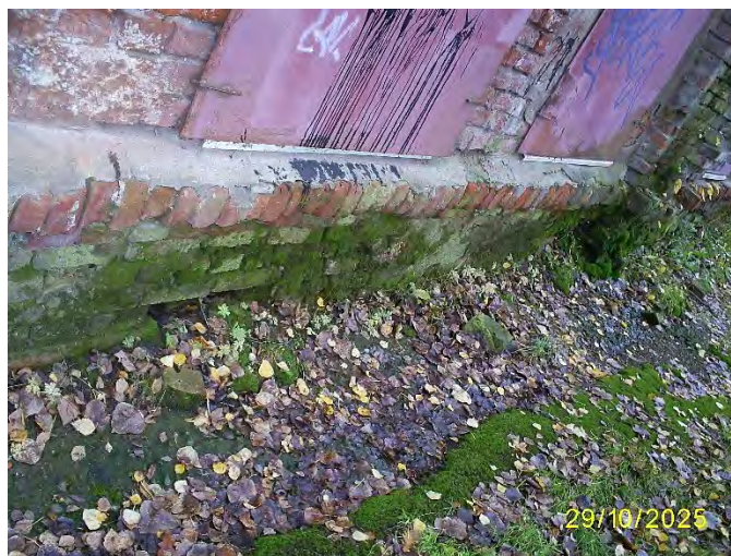
Фото 73. Часть северного фасада
