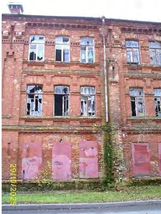
Фото 74. Часть северного фасада
