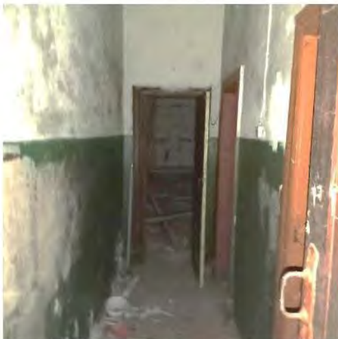
Фото 15. Вид одного из помещений 1-го этажа
