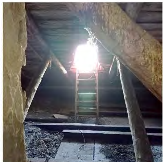
Фото 34. Вид чердачного (подкровельного) пространства и стропильной системы
