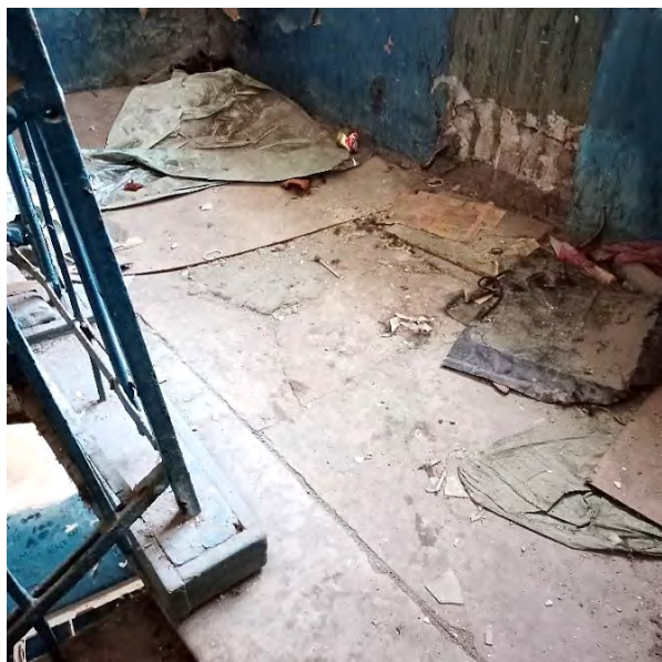
Фото 22. Лестничная площадка м/у 2 и 3 этажами
