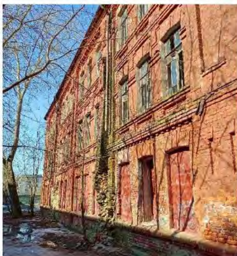
Фото 11. Вид на западную часть южного фасада
