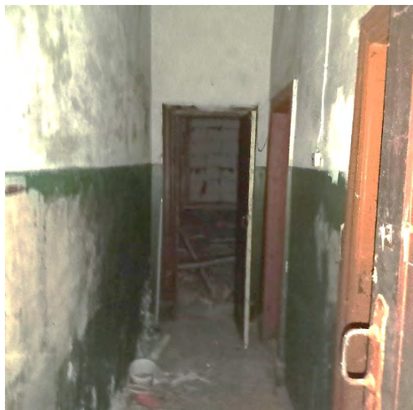
Фото 15. Вид одного из помещений 1-го этажа
