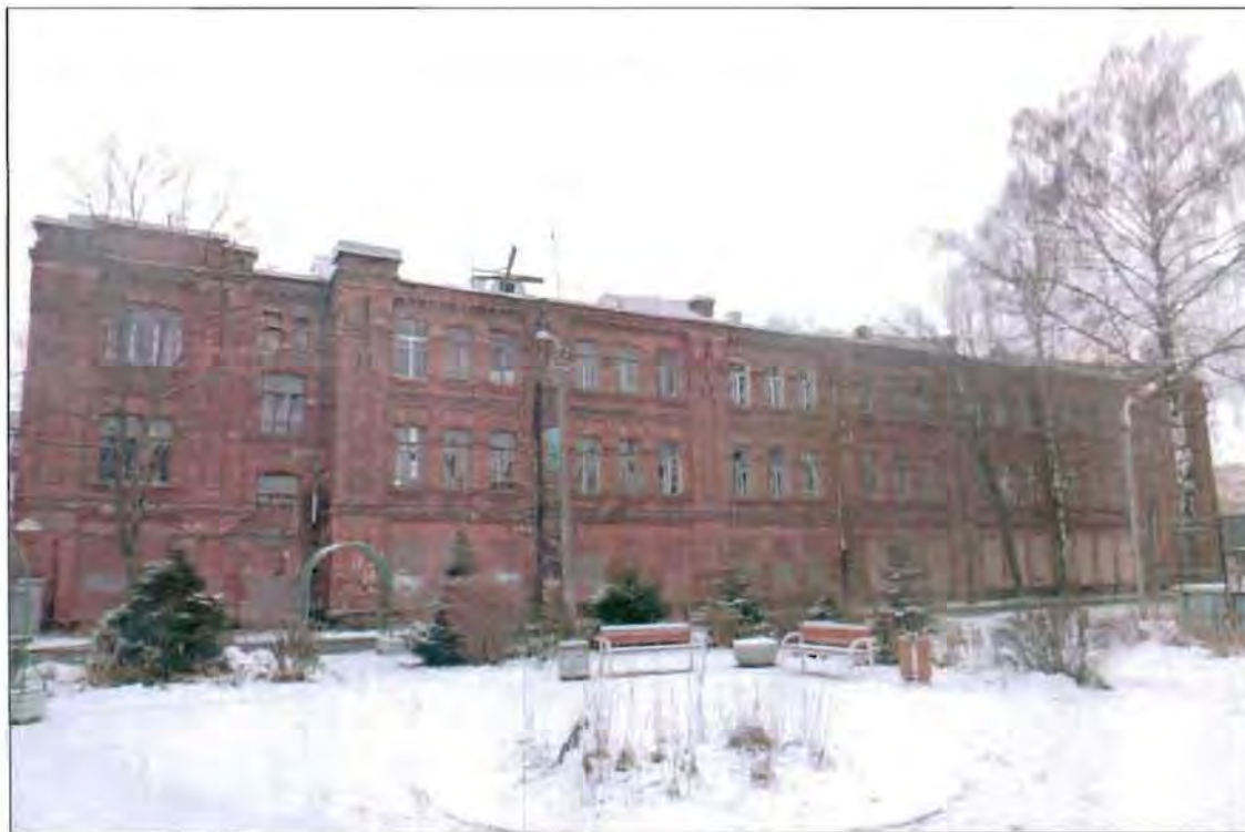
1. Общий вид северного фасада.
