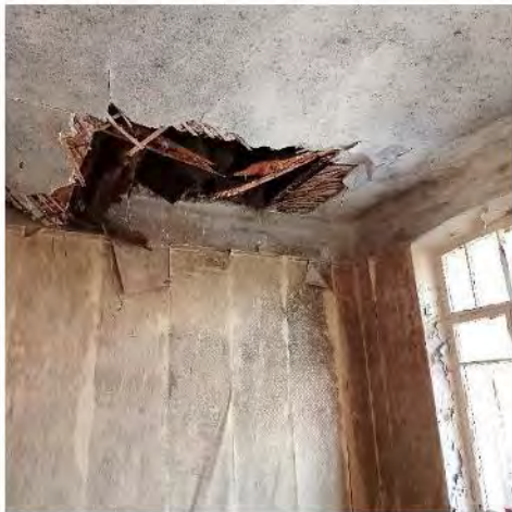
Фото 25. Вид на одно из помещений 3 этажа
