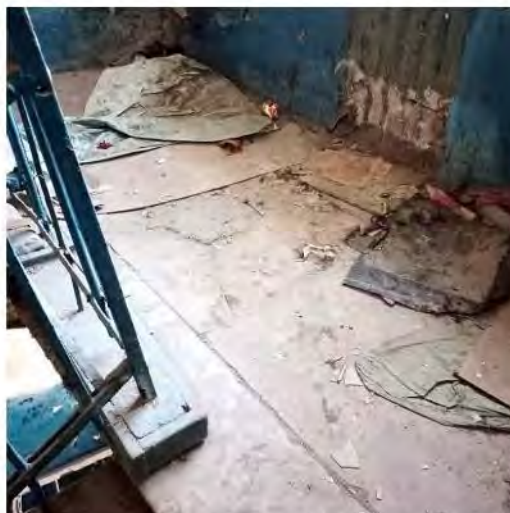
Фото 22. Лестничная площадка м/у 2 и 3 этажами
