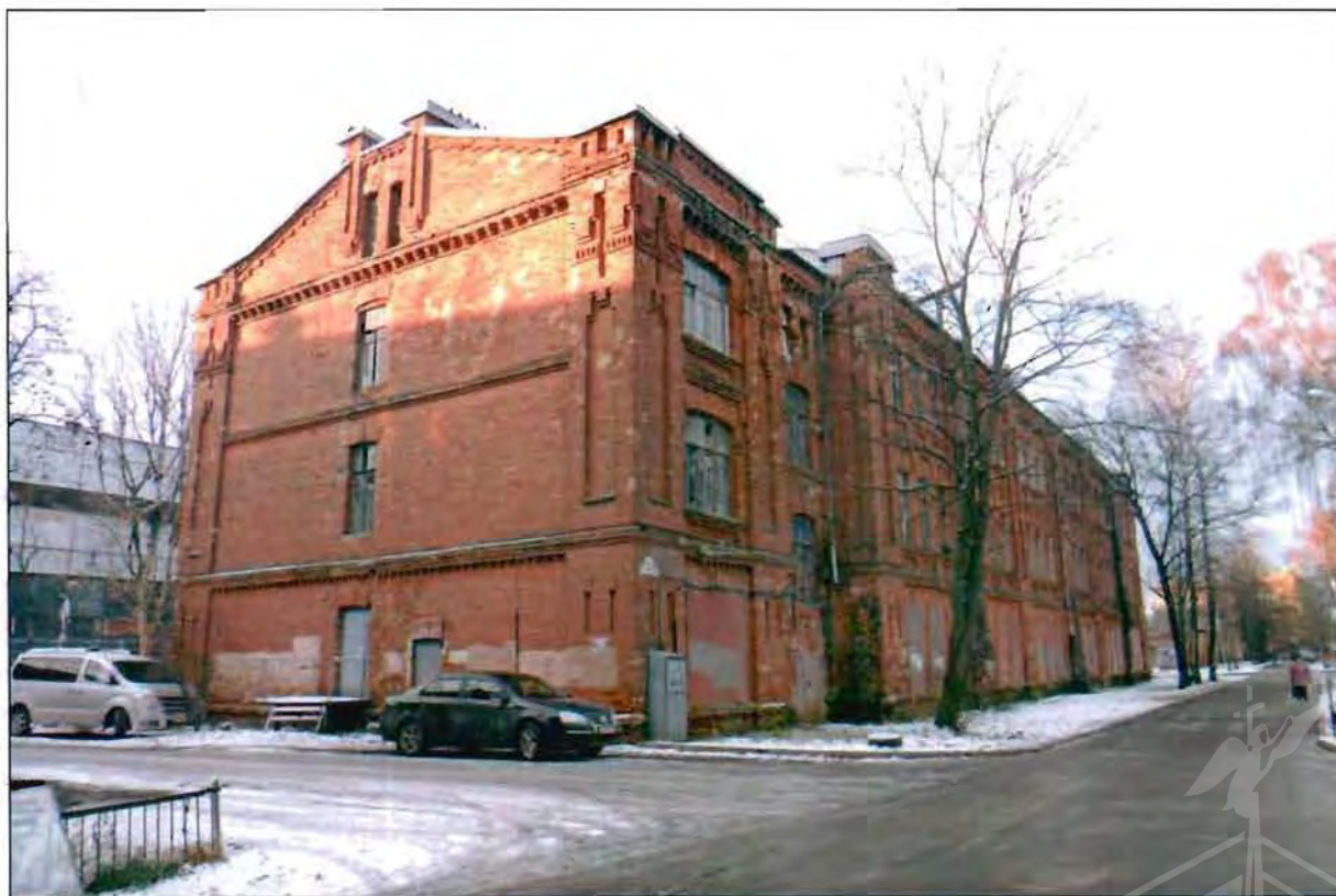
3. Общий вид с северо-востока.
