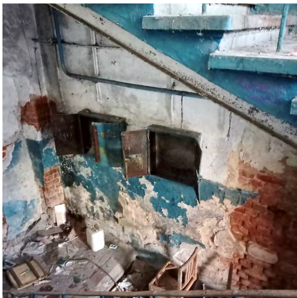
Фото 19. Вид с лестничного марша 1ЛК на 1 этаж
