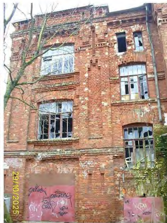
Фото 75. Часть северного фасада
