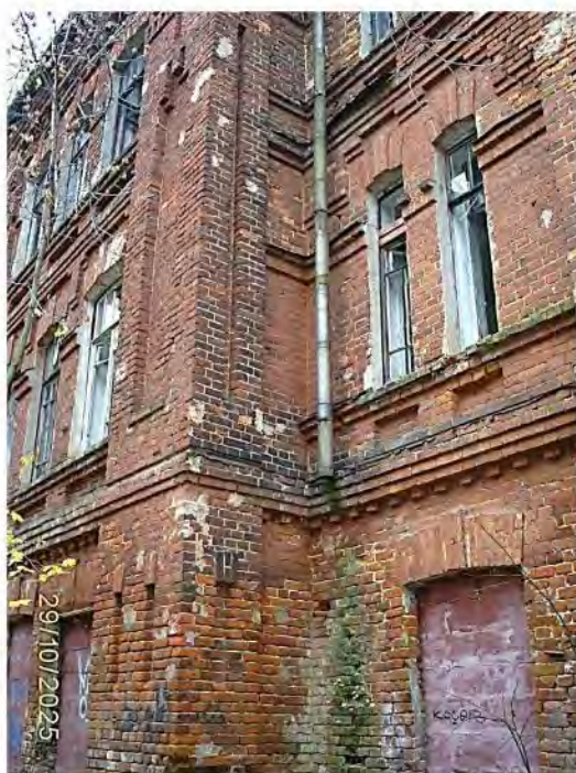
Фото 43. Часть южного фасада
