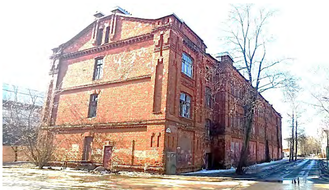
Фото 7. Вид на восточный и северный фасады
