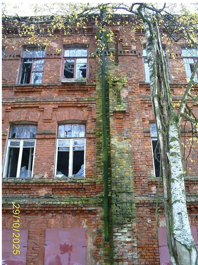
Фото 72. Часть северного фасада
