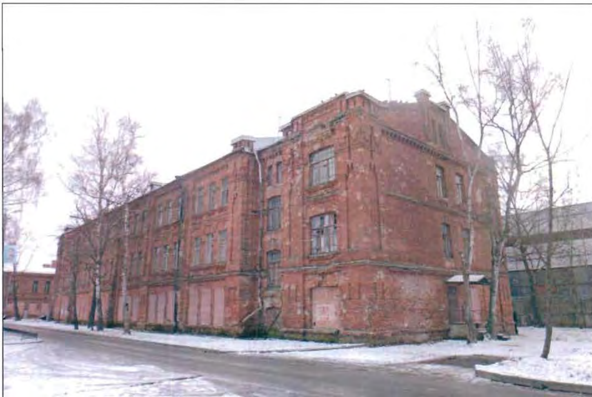
2. Общий вид с северо-запада.
