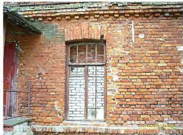
Фото 62. Часть западного фасада
