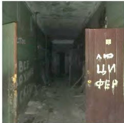
Фото 14. Вид одного из помещений 1-го этажа
