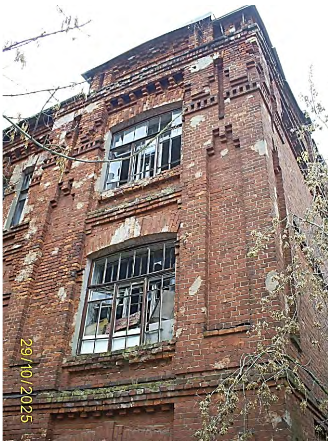
Фото 41. Часть южного фасада
