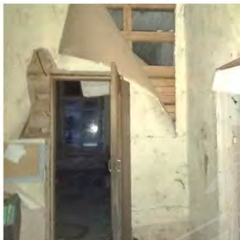
Фото 18. Вид одного из помещений 1-го этажа
