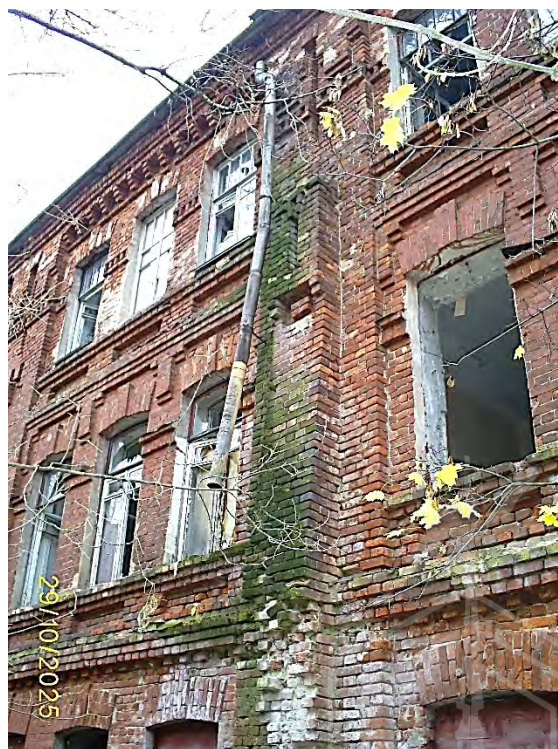
Фото 47. Часть южного фасада
