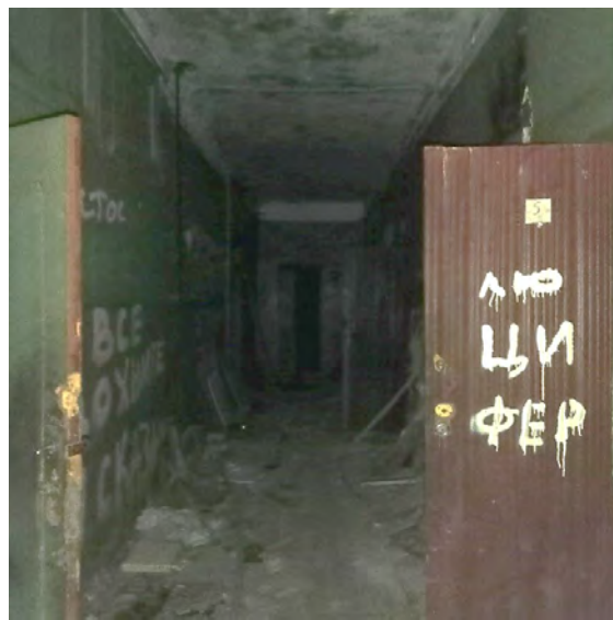
Фото 14. Вид одного из помещений 1-го этажа
