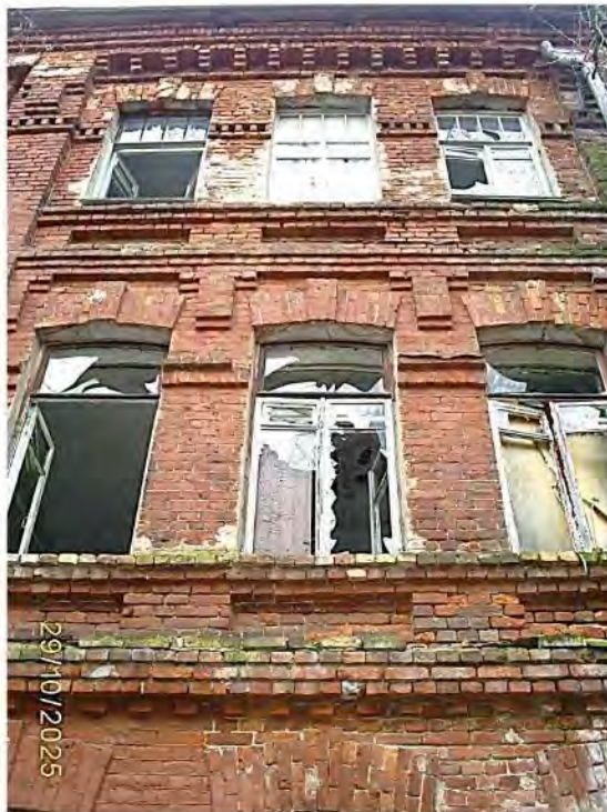
Фото 52. Часть южного фасада
