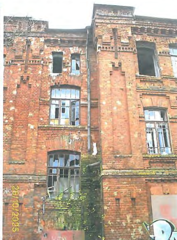
Фото 77. Часть северного фасада
