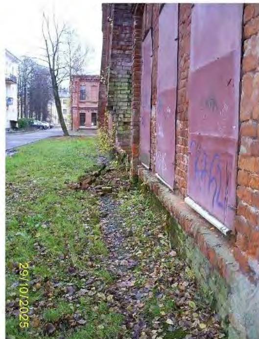
Фото 71. Часть северного фасада
