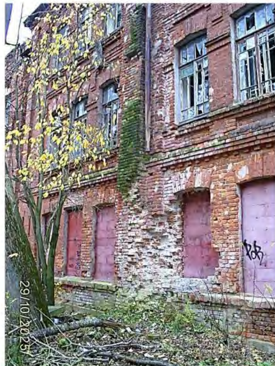
Фото 55. Часть южного фасада
