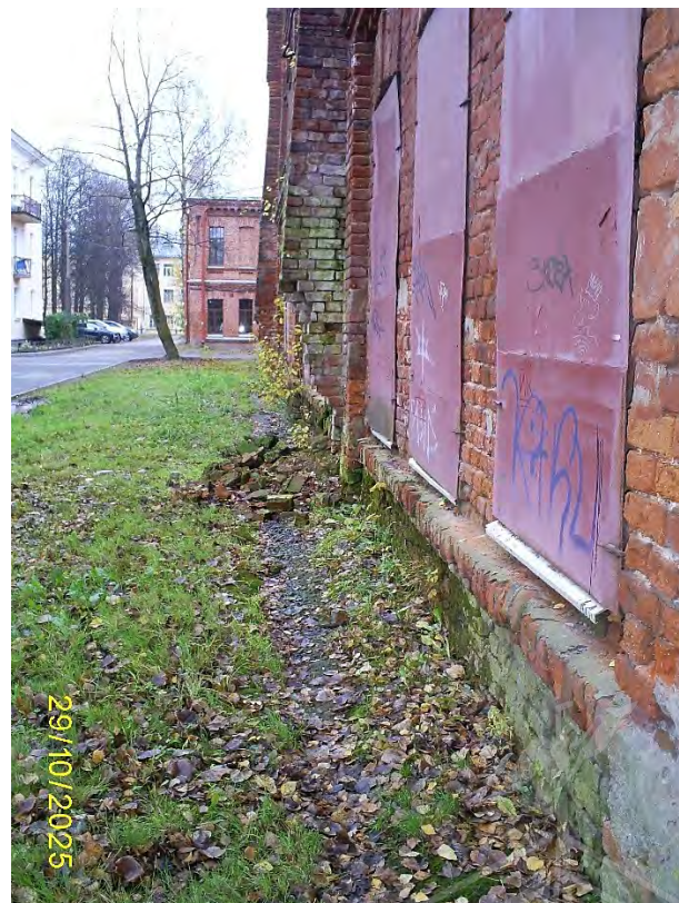
Фото 71. Часть северного фасада
