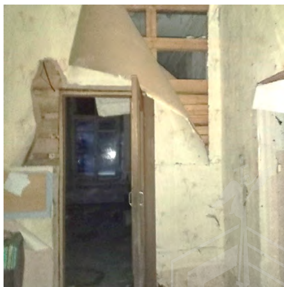
Фото 18. Вид одного из помещений 1-го этажа
