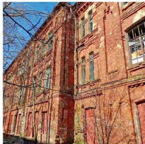
Фото 10. Вид на часть южного фасада
