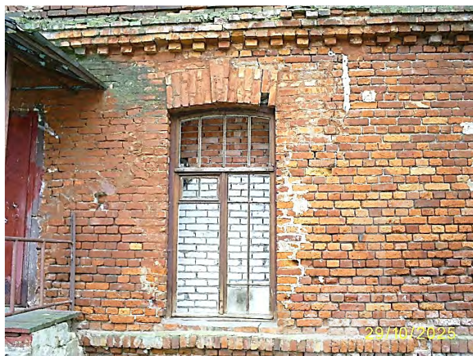
Фото 62. Часть западного фасада
