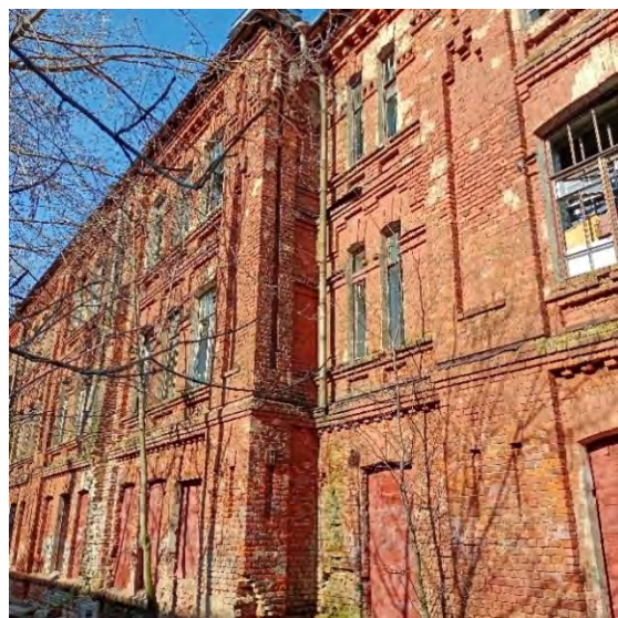
Фото 10. Вид на часть южного фасада
