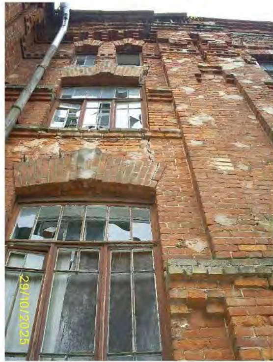
Фото 69. Часть северного фасада
