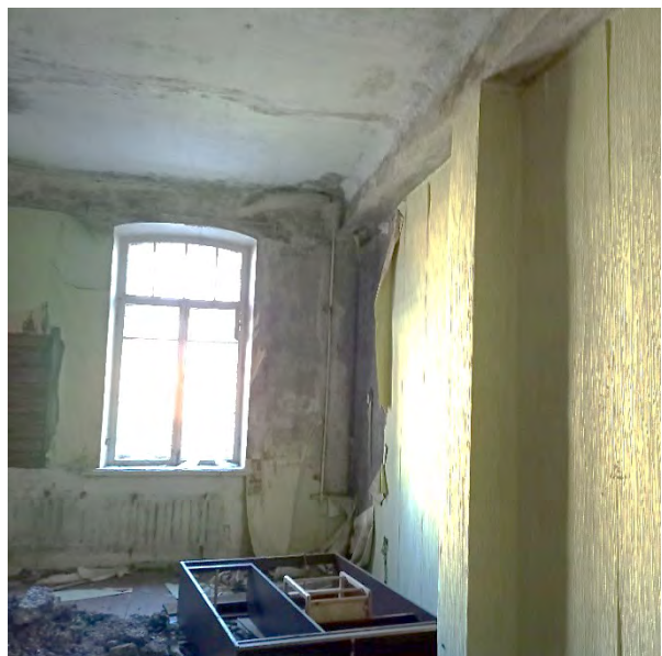
Фото 21. Вид на одно из помещений 2 этажа
