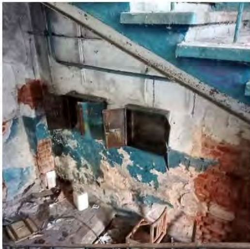
Фото 19. Вид с лестничного марша 1ЛК на 1 этаж
