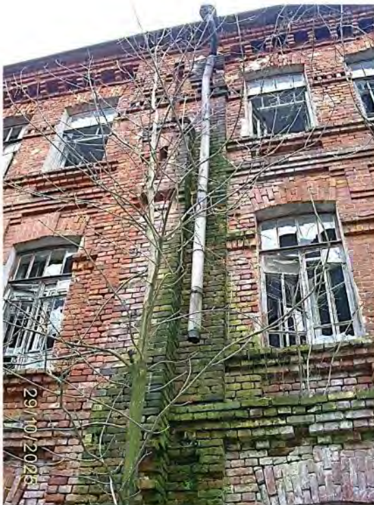
Фото 54. Часть южного фасада
