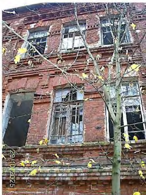
Фото 46. Часть южного фасада
