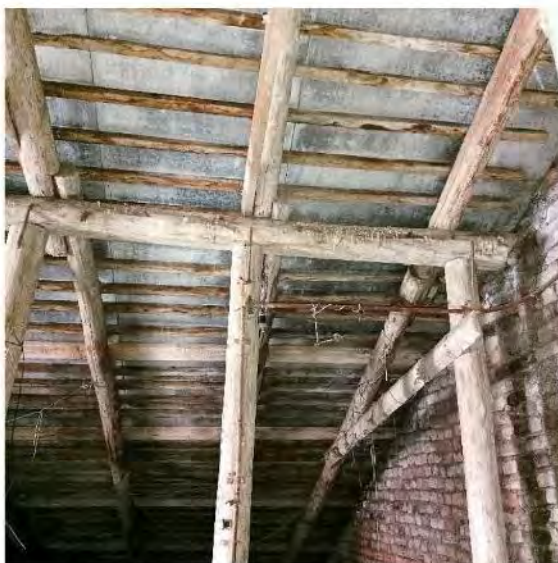
Фото 33. Вид чердачного (подкровельного) пространства и стропильной системы
