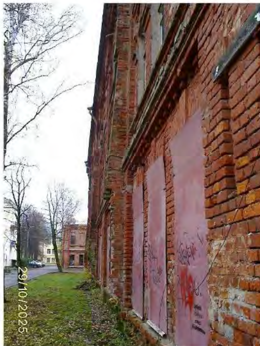
Фото 70. Часть северного фасада
