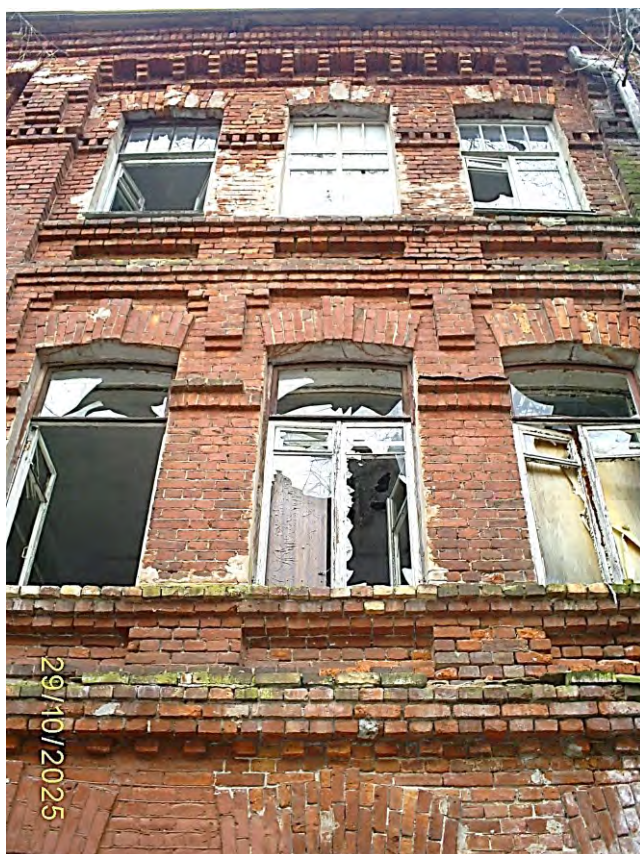
Фото 52. Часть южного фасада
