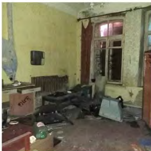
Фото 17. Вид одного из помещений 1-го этажа
