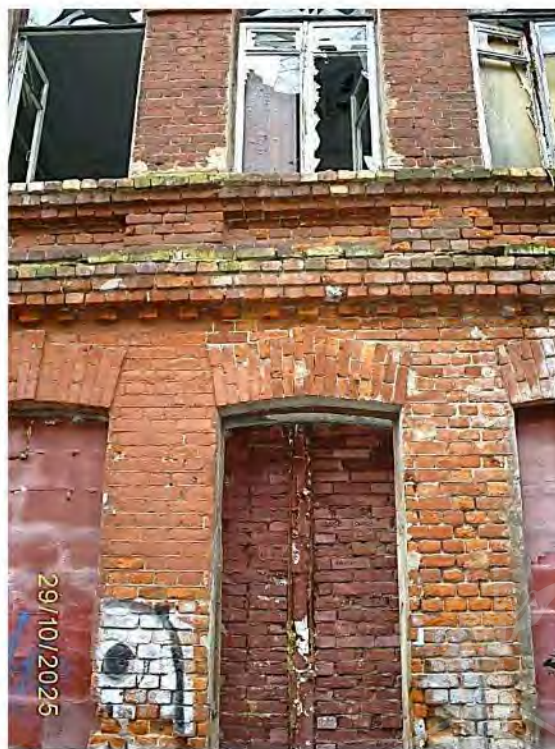
Фото 51. Часть южного фасада
