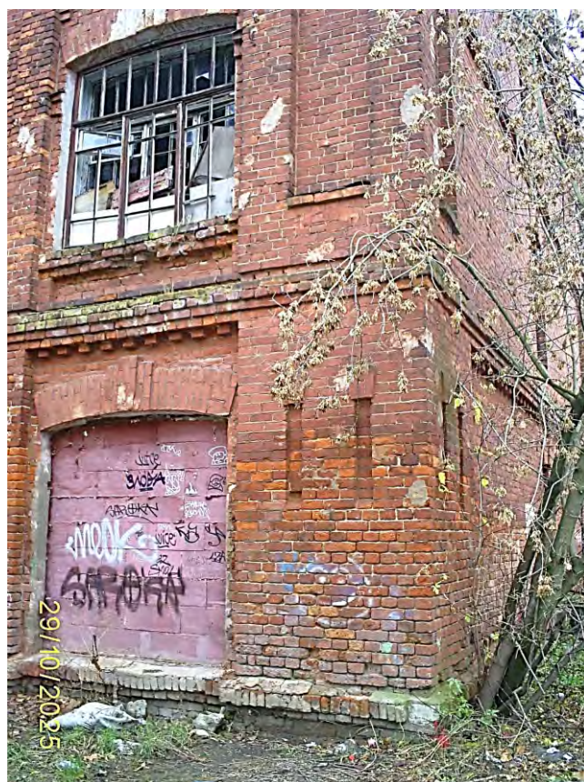
Фото 42. Часть южного фасада
