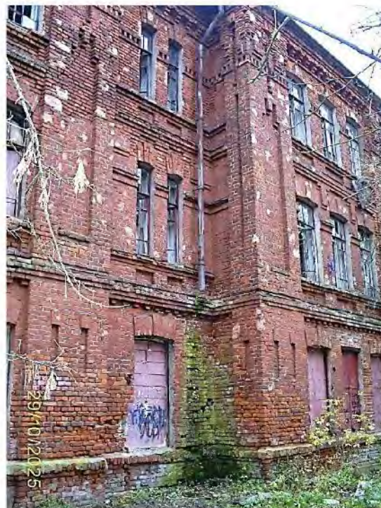
Фото 57. Часть южного фасада
