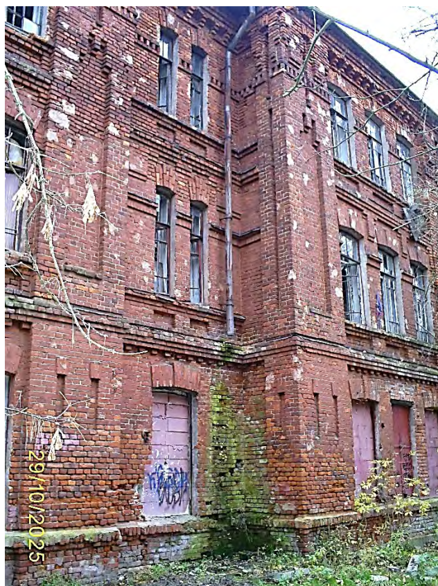
Фото 57. Часть южного фасада
