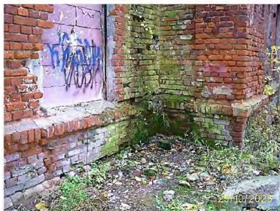
Фото 59. Часть южного фасада
