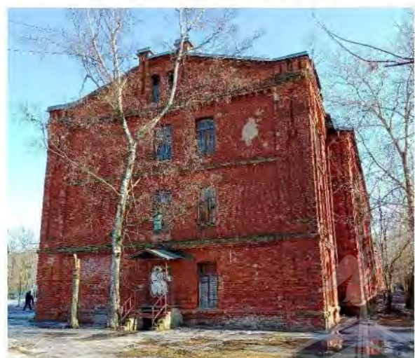
Фото 12. Вид на западный фасад
