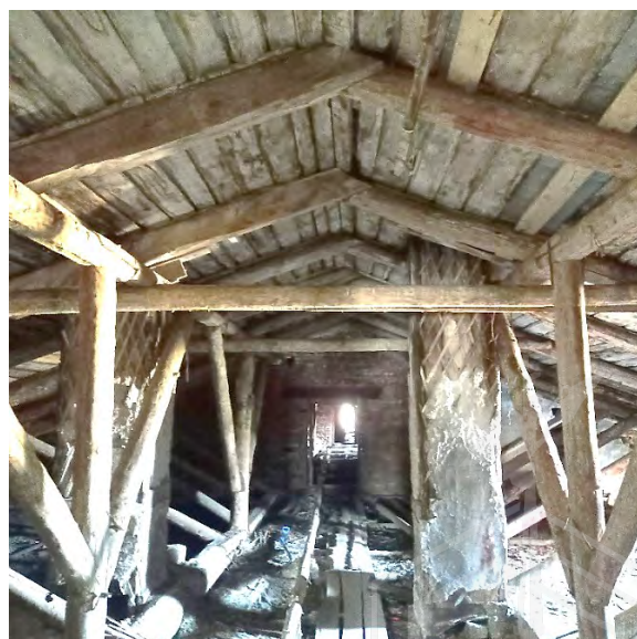
Фото 30. Вид чердачного (подкровельного) пространства и стропильной системы
