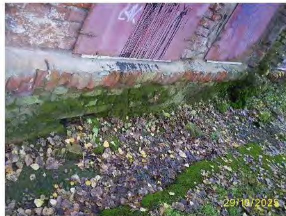
Фото 73. Часть северного фасада
