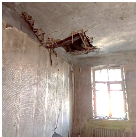
Фото 26. Вид на одно из помещений 3 этажа
