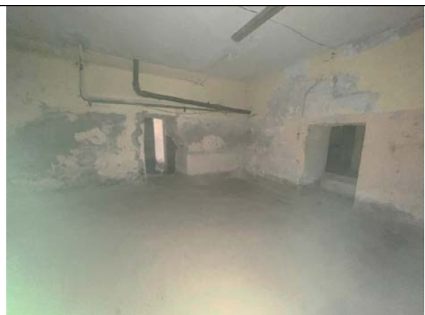
Фото 24. Типичное состояние Объекта оценки
