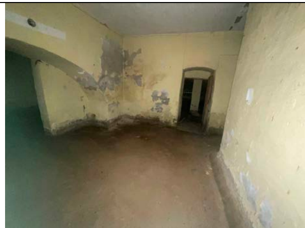
Фото 39. Типичное состояние Объекта оценки
