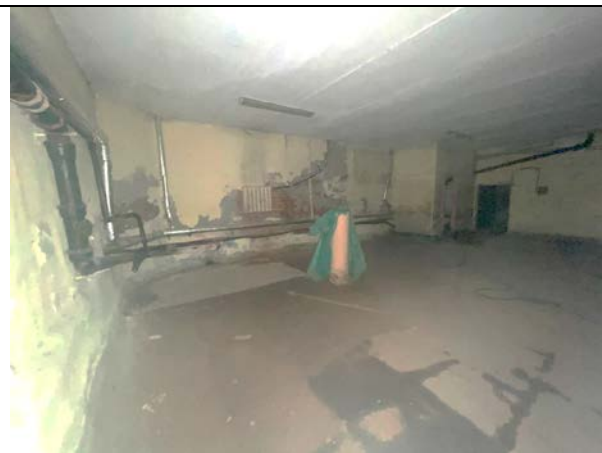
Фото 45. Типичное состояние Объекта оценки
