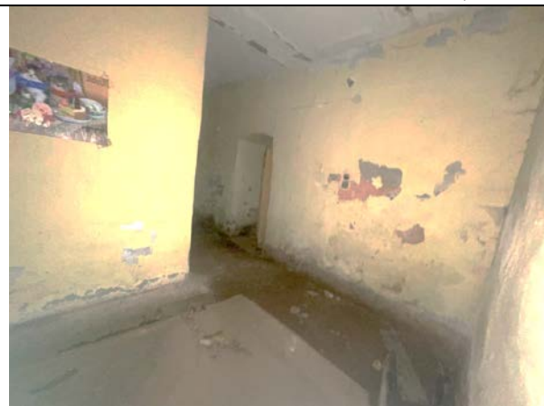
Фото 35. Типичное состояние Объекта оценки
