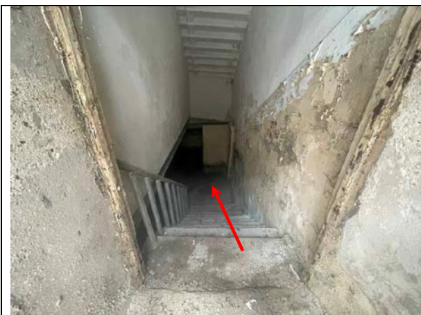
Фото 21. Лестничный проход Объекта оценки, входная группа Объекта оценки со стороны улицы
