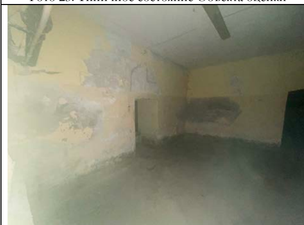
Фото 25. Типичное состояние Объекта оценки
