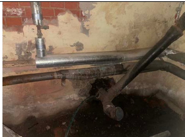
Фото 48. Типичное состояние Объекта оценки
