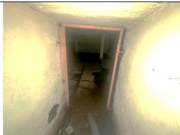
Фото 43. Типичное состояние Объекта оценки
