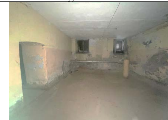
Фото 31. Типичное состояние Объекта оценки, Оконная группа Объекта оценки
