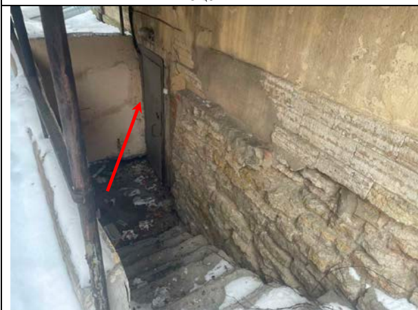
Фото 17. Входная и оконная группа Объекта оценки со стороны двора
