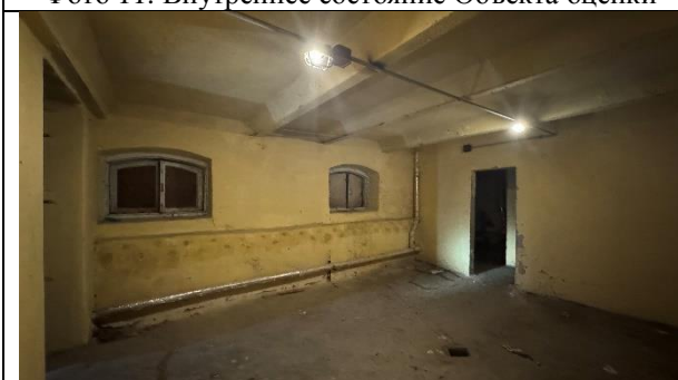
Фото 13. Внутреннее состояние Объекта оценки
