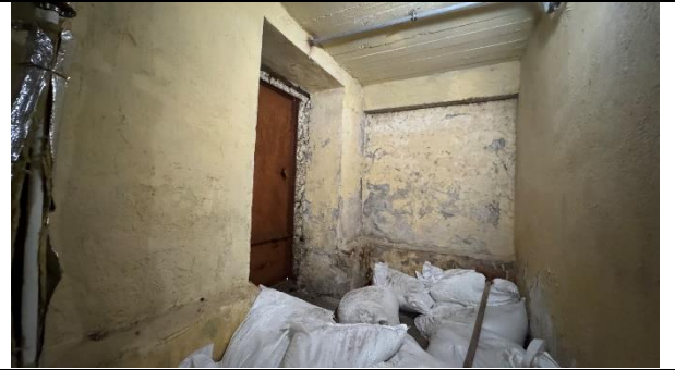
Фото 22. Внутреннее состояние Объекта оценки
