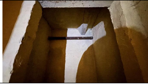
Фото 17. Внутреннее состояние Объекта оценки
