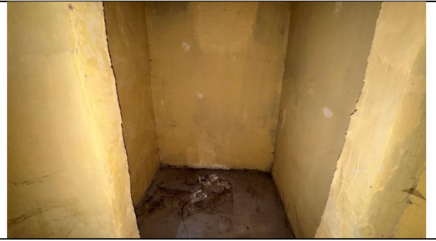
Фото 16. Внутреннее состояние Объекта оценки
