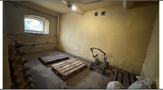
Фото 20. Внутреннее состояние Объекта оценки
