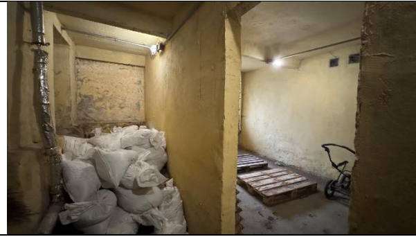
Фото 19. Внутреннее состояние Объекта оценки
