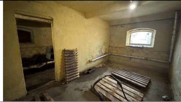
Фото 21. Внутреннее состояние Объекта оценки
