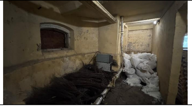
Фото 18. Внутреннее состояние Объекта оценки
