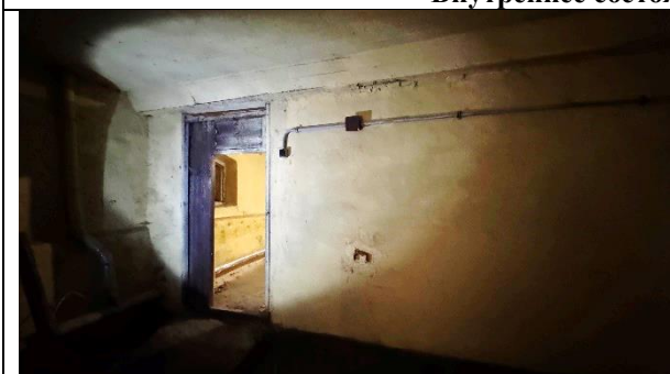
Фото 11. Внутреннее состояние Объекта оценки
