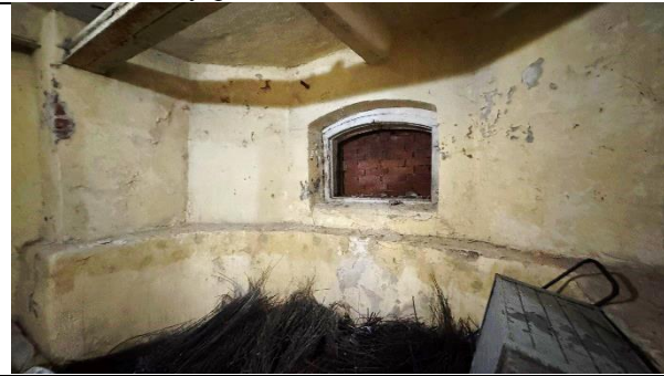
Фото 23. Внутреннее состояние Объекта оценки
