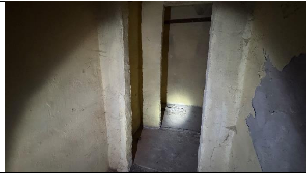
Фото 15. Внутреннее состояние Объекта оценки
