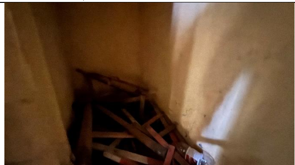
Фото 12. Внутреннее состояние Объекта оценки
