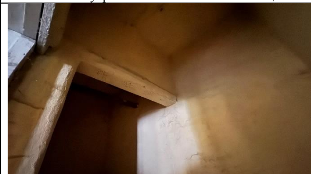
Фото 13. Внутреннее состояние Объекта оценки
