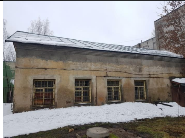
Фото 33. Вид Объекта оценки (литера Б)
