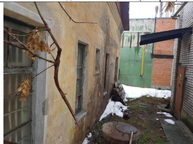
Фото 35. Вид Объекта оценки (литера Б)
