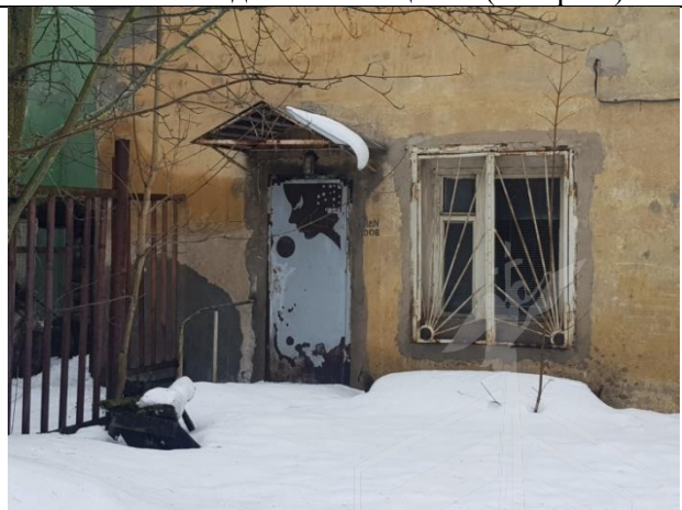
Фото 36. Вид Объекта оценки (литера Б)
