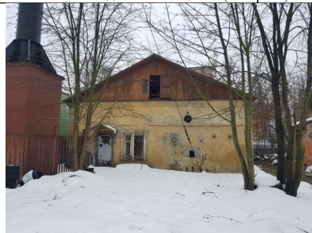
Фото 31. Вид Объекта оценки (литера Б)
