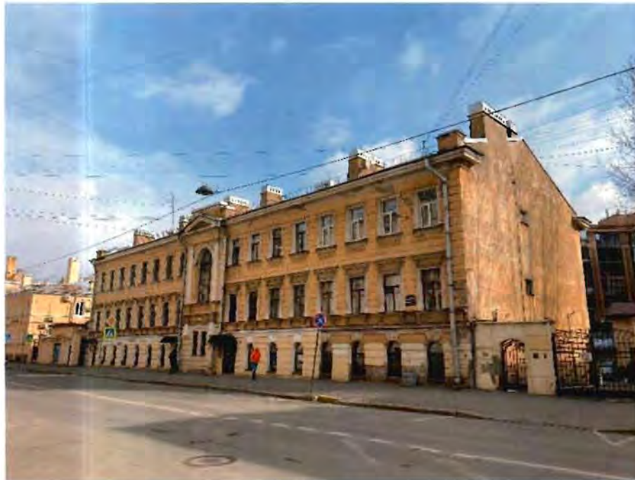
1. Общий вид на объект культурного наследия.
