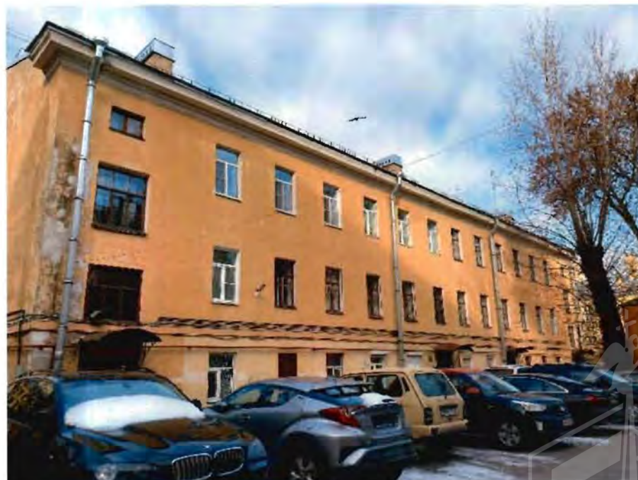
2. Общий вид на объект культурного наследия.
