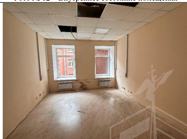
Фото № 14 – Внутреннее состояние помещения
