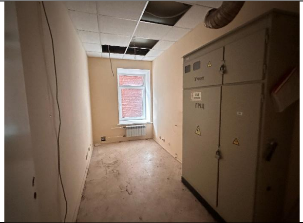
Фото № 16 – Внутреннее состояние помещения
