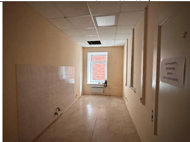
Фото № 9 – Внутреннее состояние помещения
