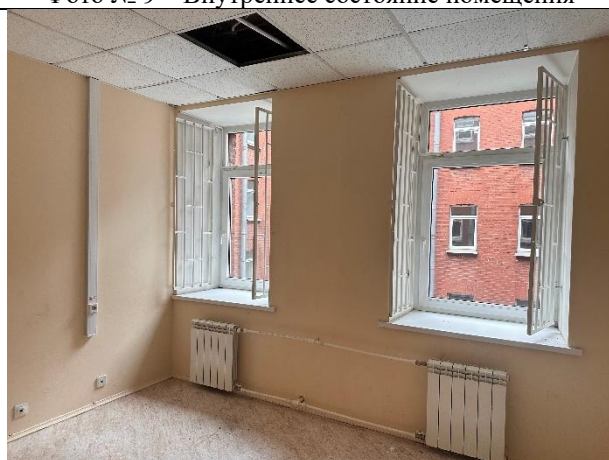
Фото № 11 – Внутреннее состояние помещения
