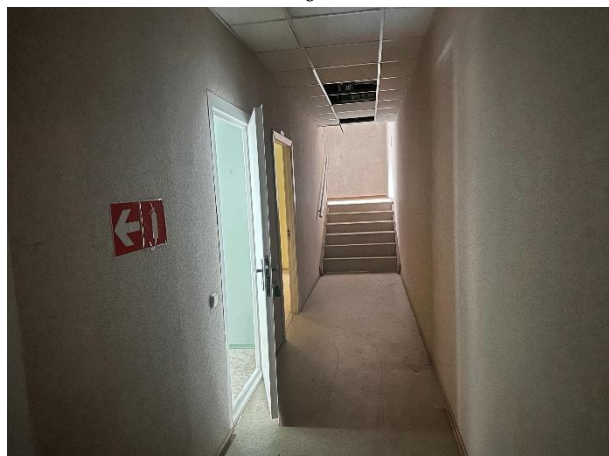
Фото № 9 – Внутреннее состояние помещения
