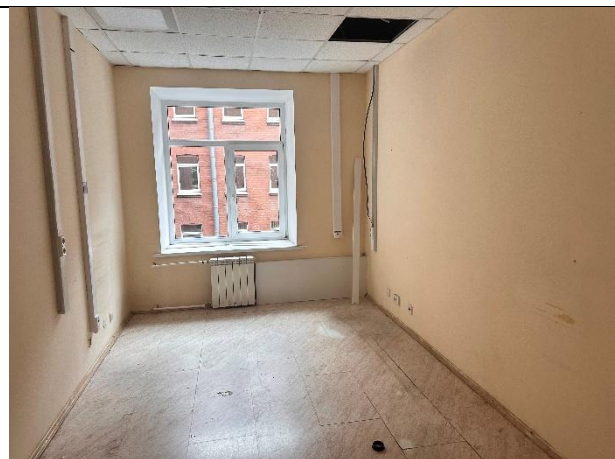
Фото № 16 – Внутреннее состояние помещения
