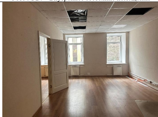
Фото № 26 – Внутреннее состояние помещения
