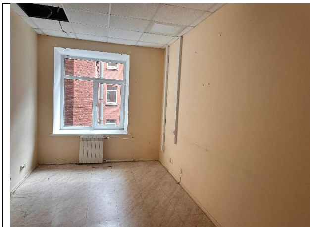
Фото № 15 – Внутреннее состояние помещения
