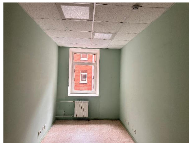
Фото № 10 – Внутреннее состояние помещения
