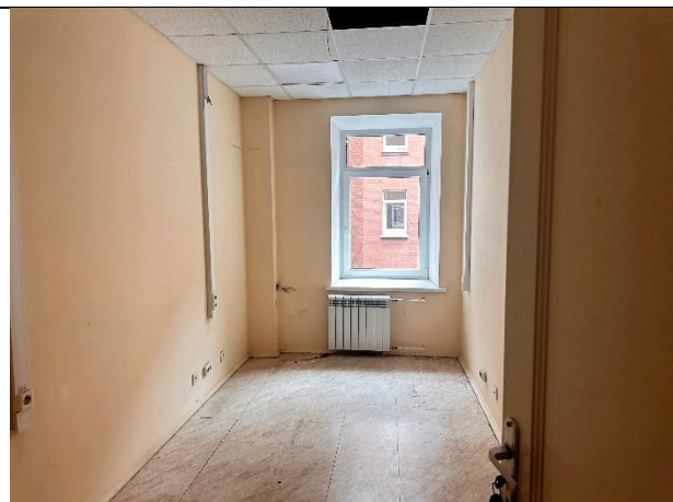
Фото № 30 – Внутреннее состояние помещения
