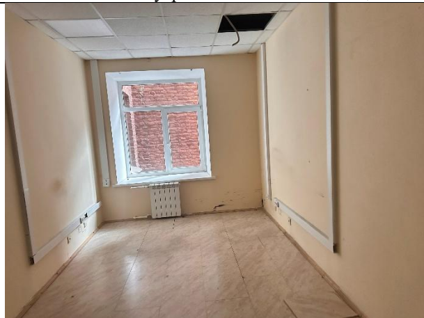
Фото № 13 – Внутреннее состояние помещения
