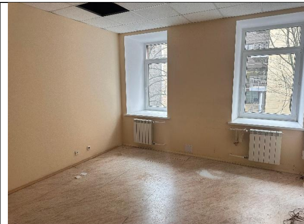
Фото № 23 – Внутреннее состояние помещения
