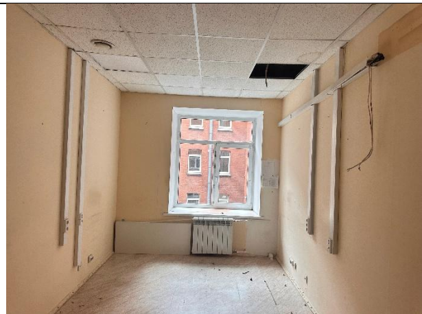
Фото № 24 – Внутреннее состояние помещения
