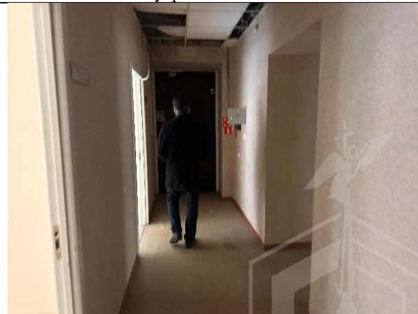
Фото № 14 – Внутреннее состояние помещения
