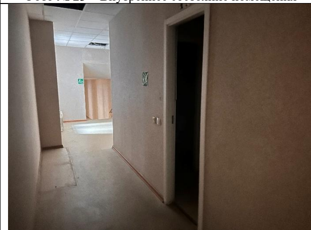
Фото № 25 – Внутреннее состояние помещения
