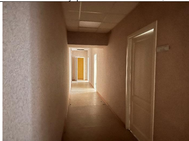
Фото № 17 – Внутреннее состояние помещения
