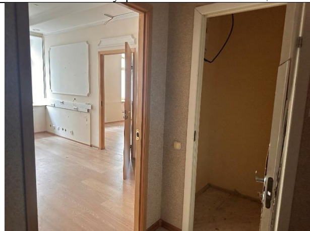
Фото № 18 – Внутреннее состояние помещения
