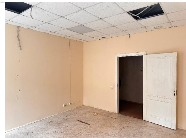
Фото № 15 – Внутреннее состояние помещения
