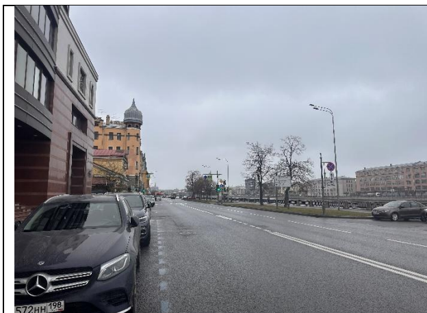
Фото № 1 – Подъездные пути и ближайшее окружение
