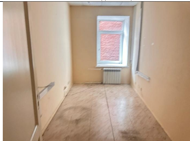
Фото № 10 – Внутреннее состояние помещения
