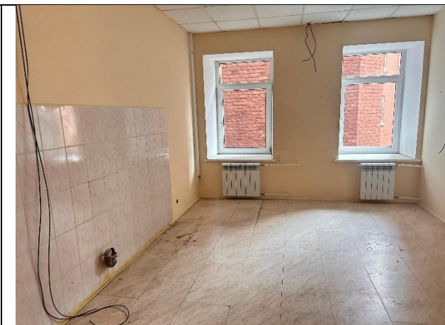
Фото № 16 – Внутреннее состояние помещения
