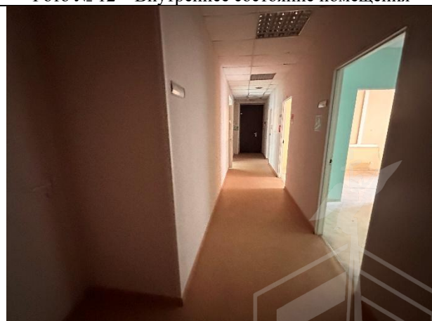
Фото № 14 – Внутреннее состояние помещения
