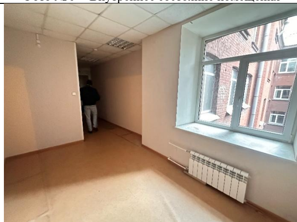
Фото № 11 – Внутреннее состояние помещения
