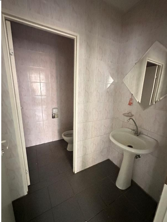
Фото № 17 – Внутреннее состояние помещения
