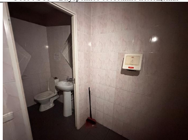
Фото № 12 – Внутреннее состояние помещения
