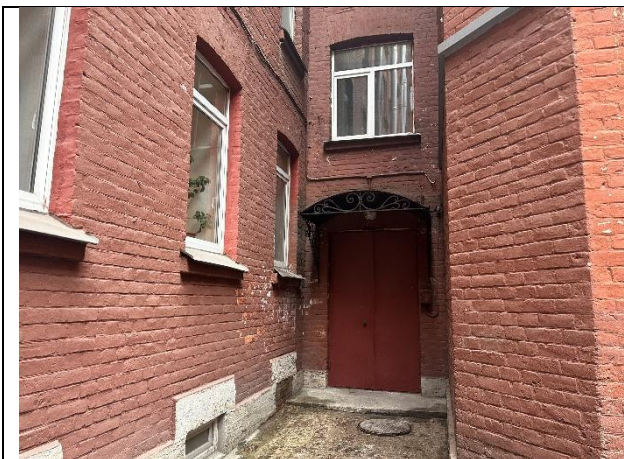
Фото № 7 – Общий вход со двора
