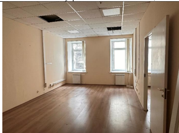
Фото № 15 – Внутреннее состояние помещения
