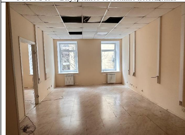
Фото № 21 – Внутреннее состояние помещения
