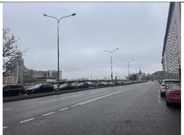
Фото № 2 – Подъездные пути и ближайшее окружение
