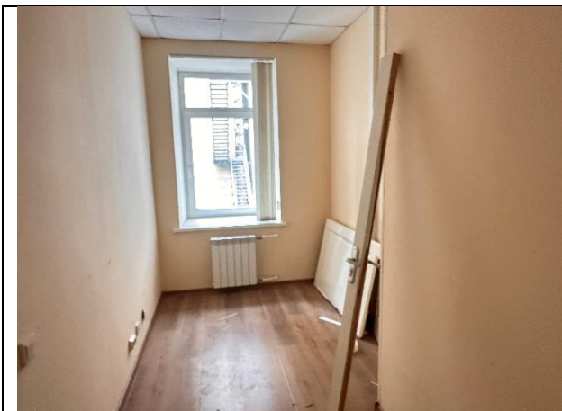
Фото № 19 – Внутреннее состояние помещения
