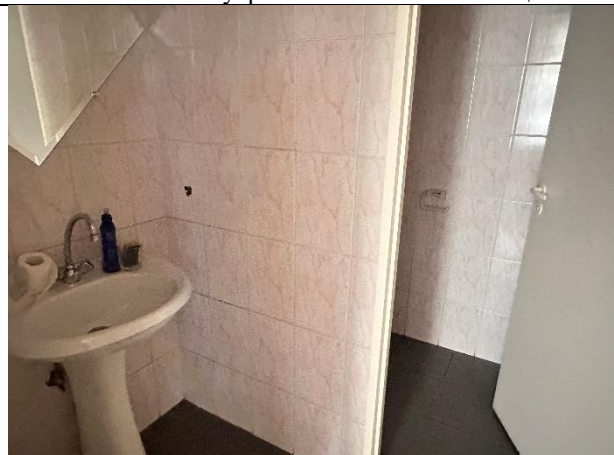
Фото № 16 – Внутреннее состояние помещения
