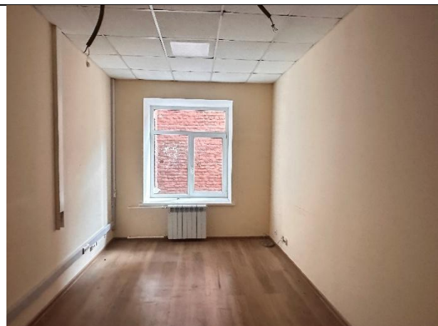
Фото № 20 – Внутреннее состояние помещения
