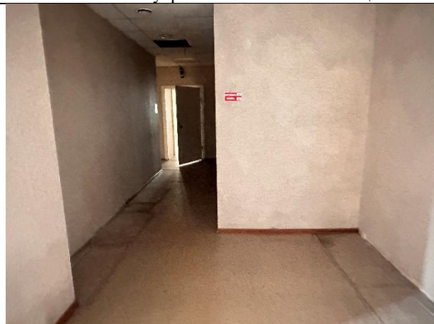
Фото № 11 – Внутреннее состояние помещения
