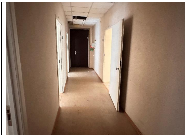
Фото № 13 – Внутреннее состояние помещения
