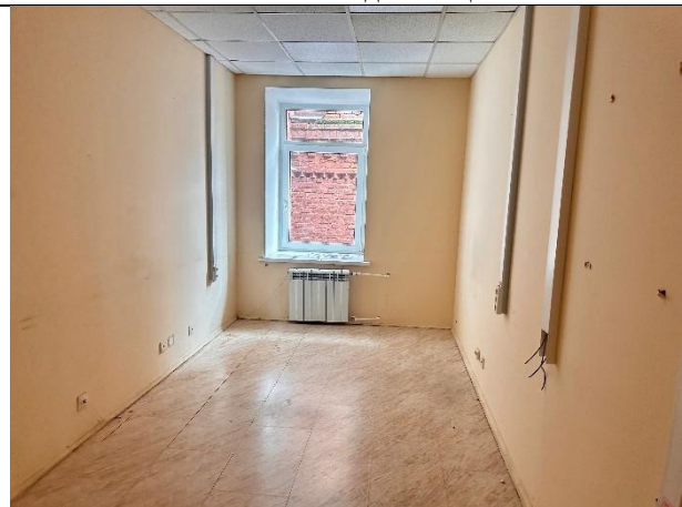
Фото № 10 – Внутреннее состояние помещения
