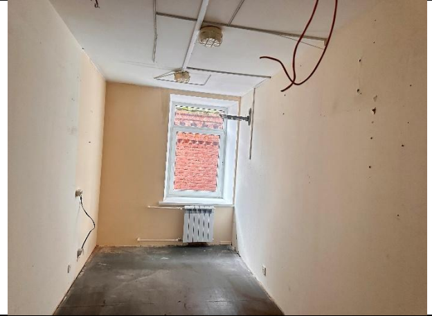
Фото № 16 – Внутреннее состояние помещения
