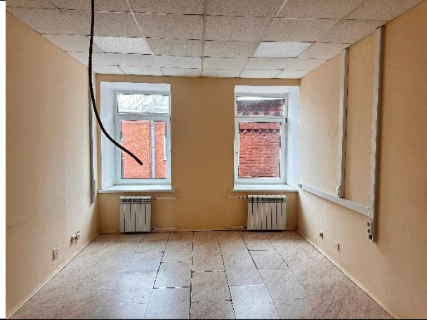
Фото № 15 – Внутреннее состояние помещения
